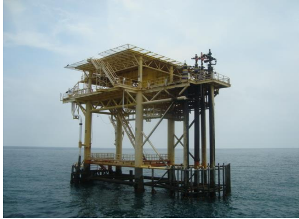
Figura 1.11 Sistema Tetrápodo
