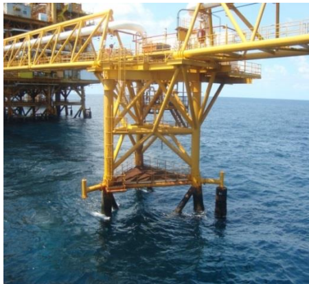
Figura 1.9 Sistema Trípode
