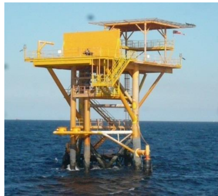
Figura 1.10 Sistema Trípode de tres columnas
