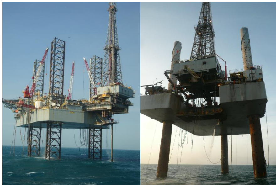
Figuras 1.15 y 1.16 de las plataformas Autoelevables actuales e iniciales respectivamente.
