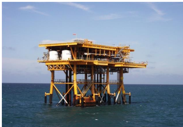
Figura 1.13 Sistema Octapodo
