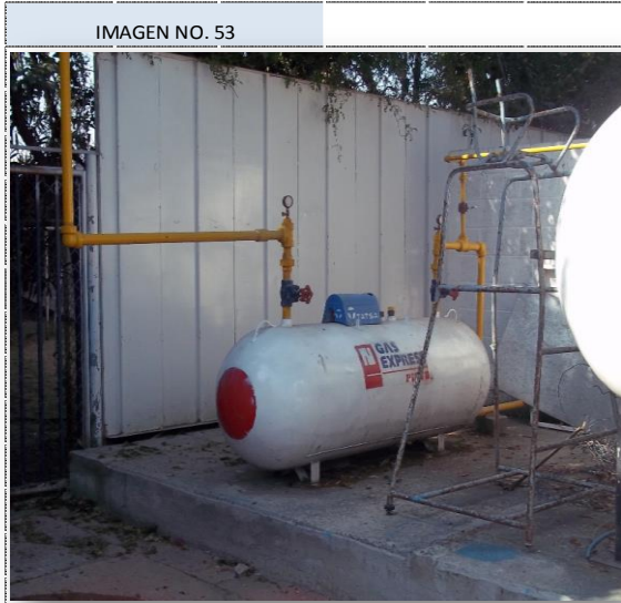
IMAGEN DE LOS TANQUES DE GAS L.P. TOMADA POR JESUS HERNANDEZ CARRASCO EN ABRIL DEL 2014
