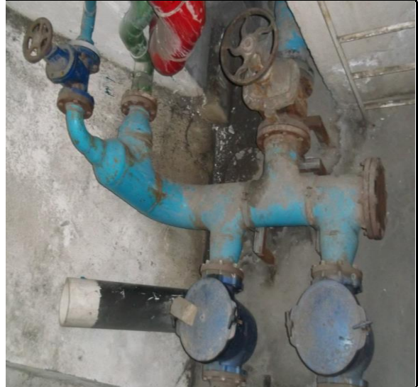
IMAGEN 59 CABEZAL DE SUCCION TOMADA POR JESUS HERNANDEZ CARRASCO EN ABRIL DEL 2014
