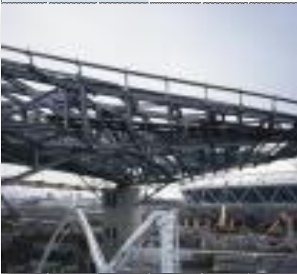
IMAGEN NO. 18 IMAGEN PROCESO CONSTRUCTIVO TOMADA DE LA PAGINA WEB DEL ACUATIC CENTRE LONDRES
