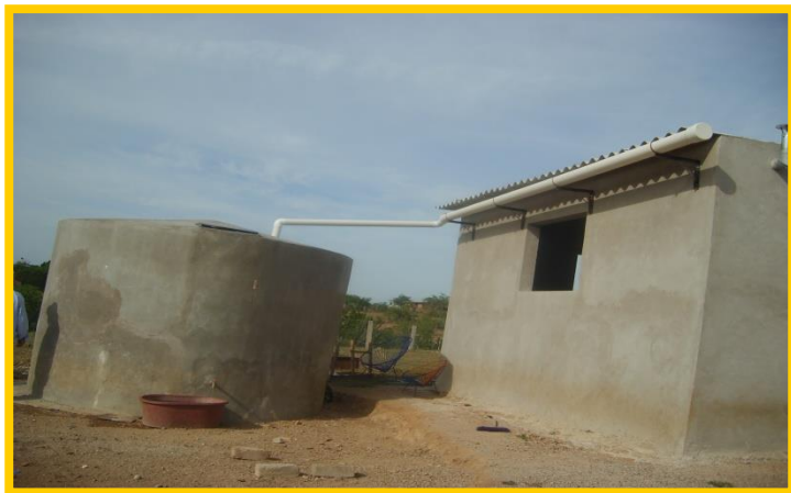
Cisterna y cubierta de captación
