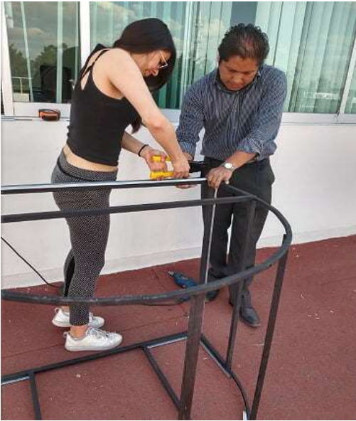
Fig. 2.10. Colocación de remaches.
