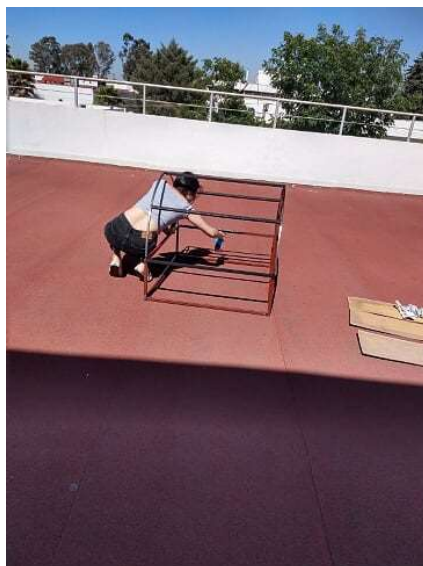
Fig. 2.7. Recubrimiento del prototipo con pintura anticorrosión
