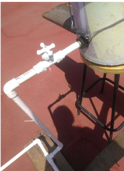
Fig. 2.30. Adaptación de tubería a bote con capacidad de 20 litros
