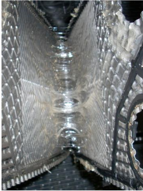
Figura 1.3 Polímero líquido residual adherido en intercambiador.
