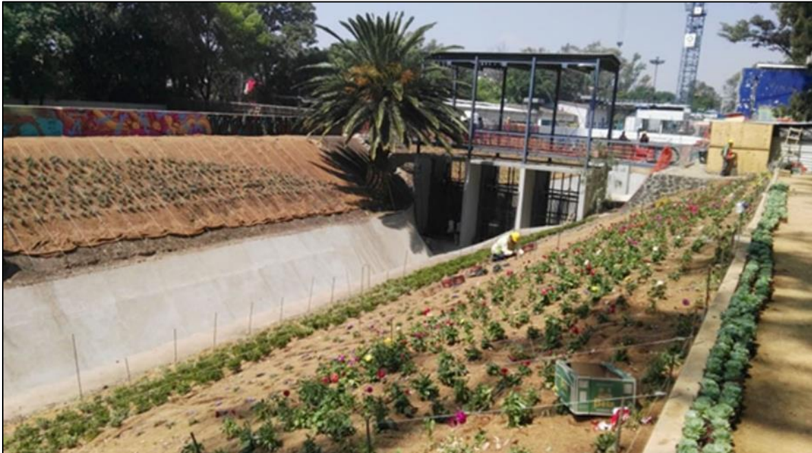
Figura 3. Revegetación de talud de canal de drenaje. Fuente: SEDEMA, 2020.
