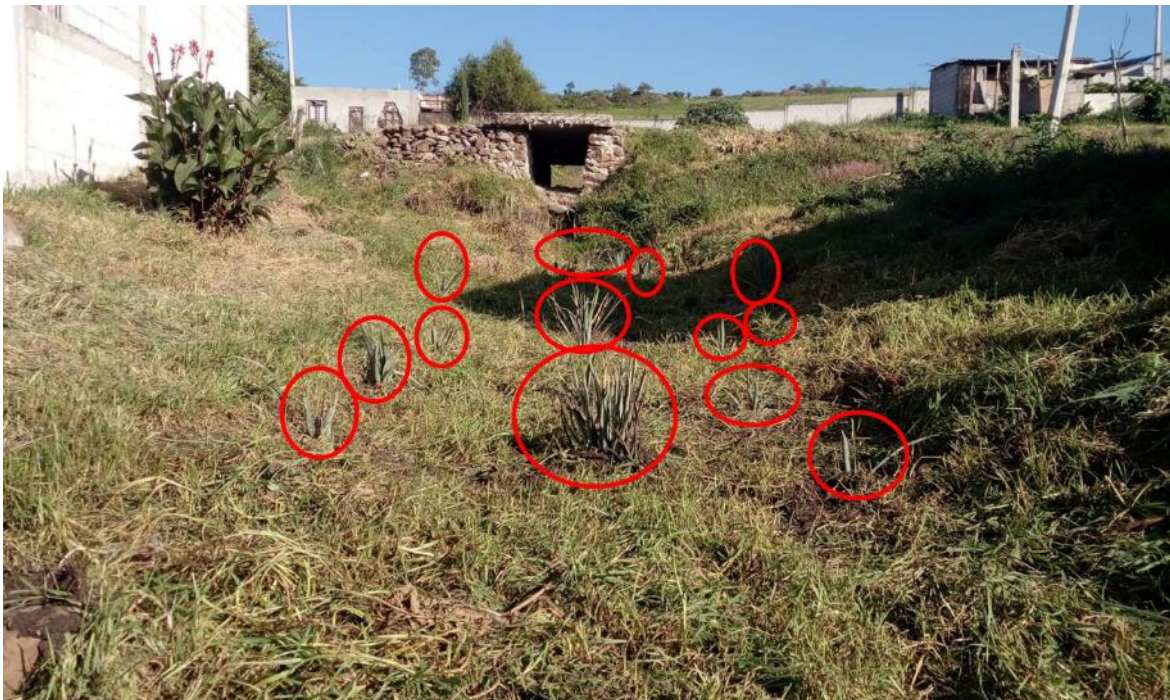
Figura 44. Vista en dirección aguas arriba, de la disposición de las plantas (círculos rojos), de tal forma que formen barreras vivas perpendiculares a la dirección del afluente.
