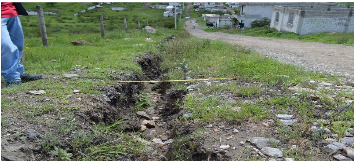
Figura 38. Cunetas implementadas por los habitantes, en este caso de 40 x 40 cm.
