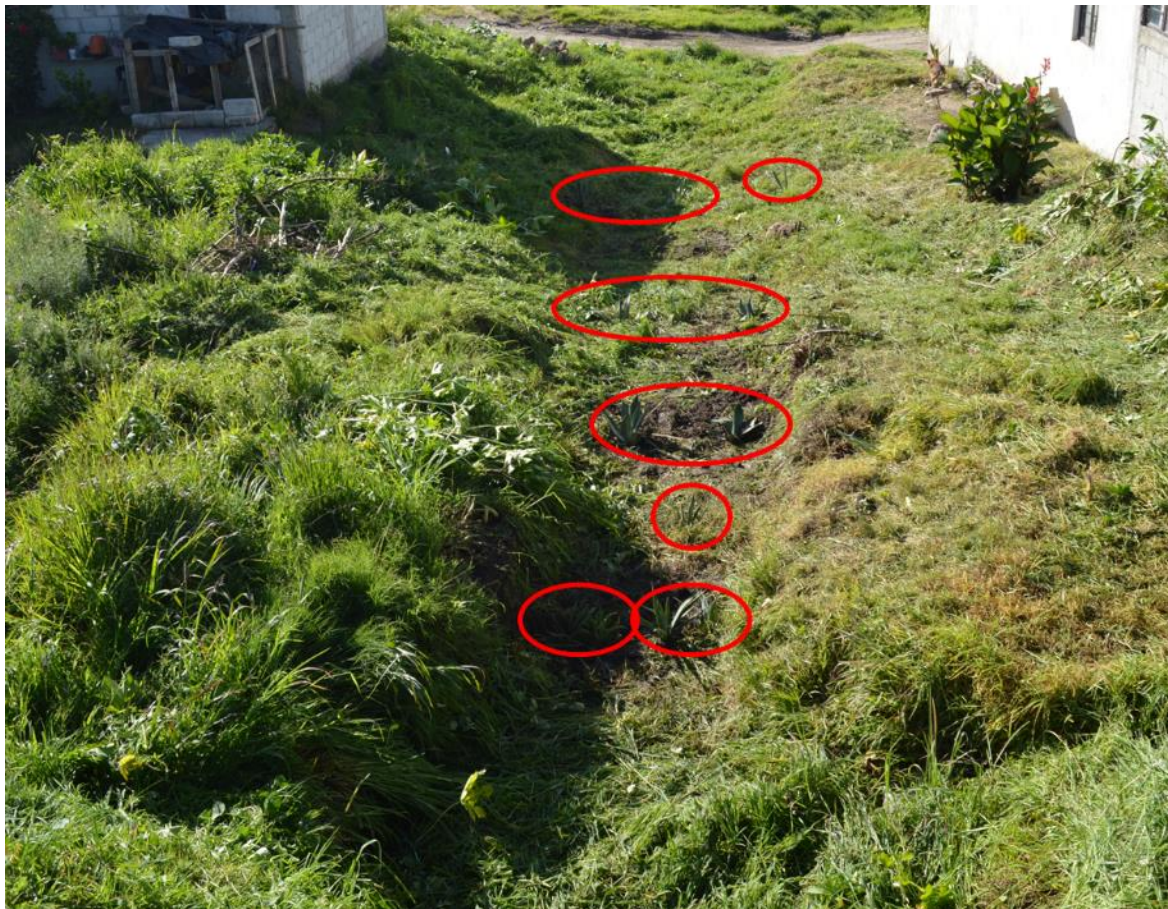
Figura 43. Vista en dirección aguas abajo, de la disposición de las plantas (círculos rojos) de tal forma que forman barreras vivas perpendiculares a la dirección del afluente. Fuente: Acosta, 2021.
