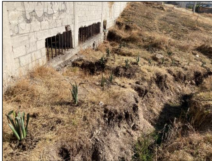
Figura 50. Resultado de la siembra de plantas de agave en el sitio donde la barda perimetral permite el acceso de la escorrentía al interior de la colonia. Fuente: Acota, 2022.
