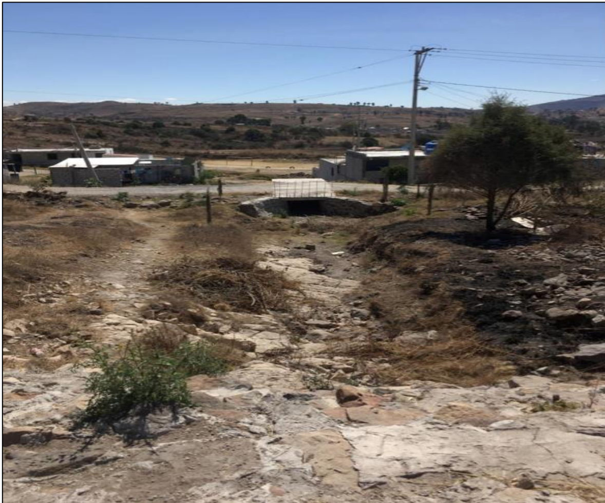
Figura 13. Formación de cárcavas dentro de la colonia Cuitláhuac. Fuente: Acosta, 2020.
