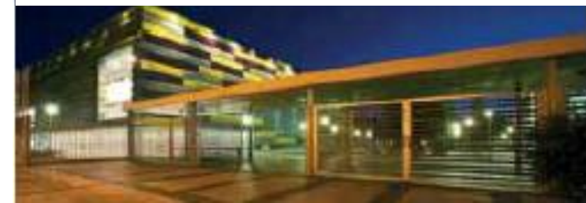
Entrada Principal Complejo Deportivo
