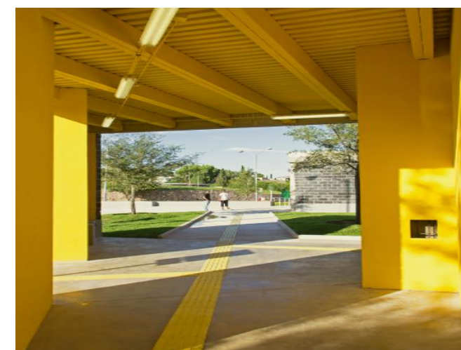
Forma del acceso principal al Gimnasio
