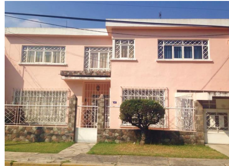
Fachada principal de la casa ubicada en la calle Matamoros número 49 en la colonia La Paz. Fuente: Liliana González tomada en Marzo 2015
