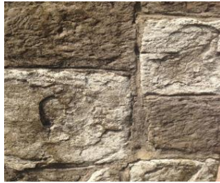
Muro de Piedra Rustica de Cantera, colocado en la fachada al exterior
