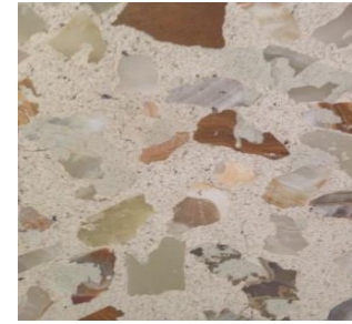
Piso de cemento con granito incrustado usado para el área del jardín al exterior
