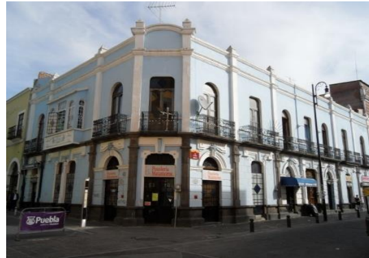
Fachada con variedad de formas y ornamentación Fuente: Archivo CA Estudios Arquitectónicos (2011)
