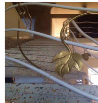
Escalera helicoidal con detalles en herrería recubierta con pintura blanca y dorada.
