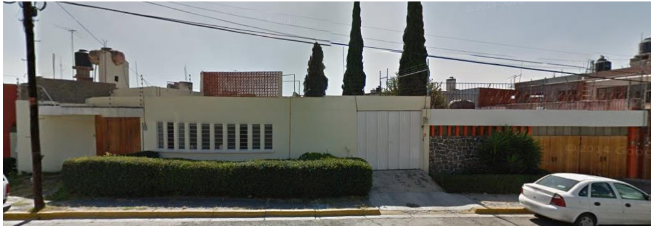
Fachada Principal de la Casa Ubicada en Tehuacán Sur número 98 en la colonia La Paz. Fuente: Liliana González tomada en Marzo 2015
