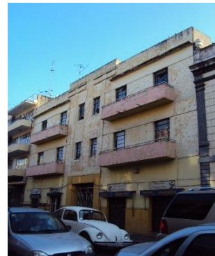
Edificio de Uso Mixto. Avenida Reforma. Fuente: Archivo CA. Estudios Arquitectónicos. Nov 2011
