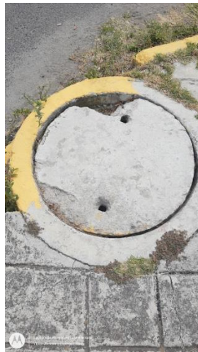
Figura 12. Red de drenaje
