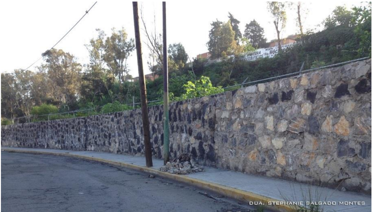
Ilustración 17. Banquetas obstruidas por infraestructura. Salgado Montes, 2013.
