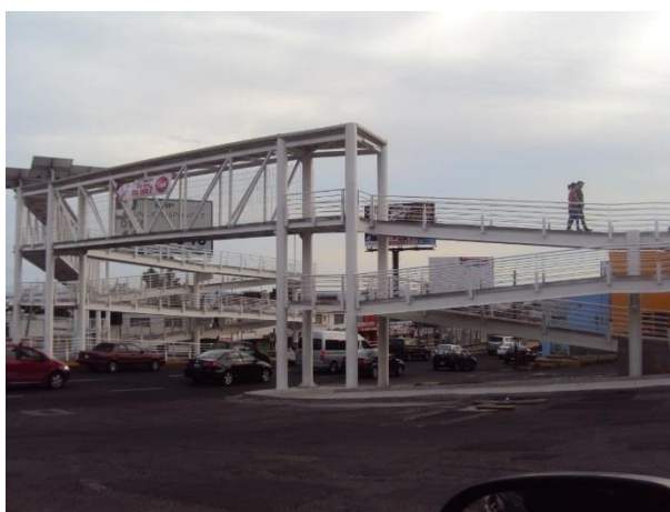
Ilustración 30. Puente peatonal en Boulevard Atlixco y 23 sur. Salgado Montes, 2013.
