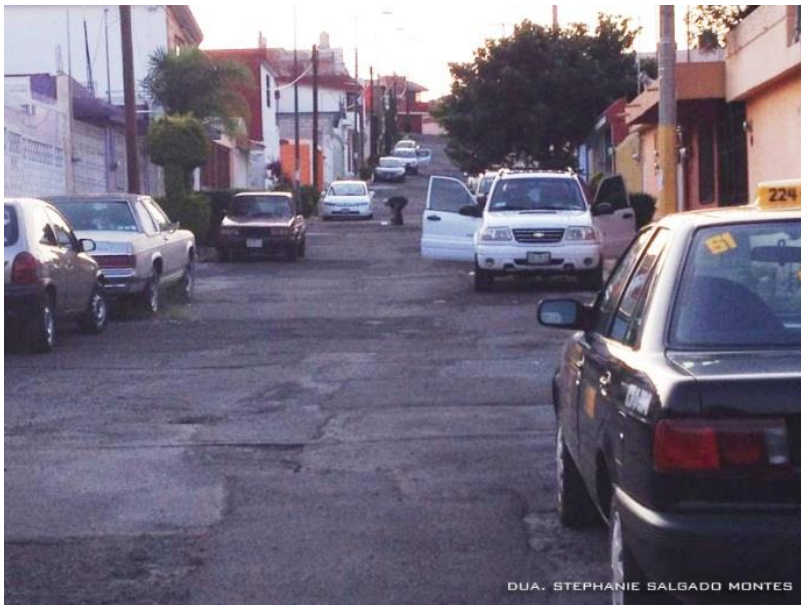
Ilustración 24. Vecinos tapando baches. Salgado Montes, 2014.
