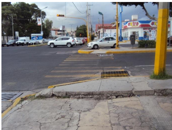
Ilustración 29. Rampas para personas con capacidades diferentes en 31 oriente y 14 sur. Salgado Montes, 2013.
