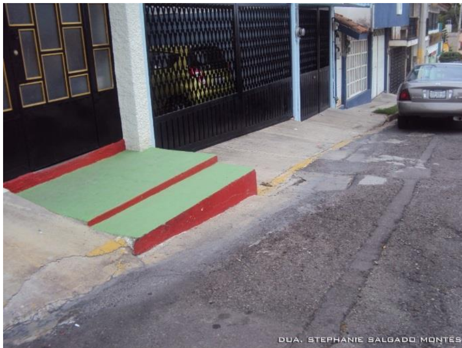
Ilustración 18. Modificación a las banquetas por los accesos a viviendas particulares. Salgado Montes, 2013.
