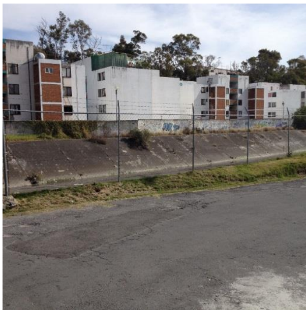
Ilustración 36. Revestimiento de concreto del río Alseseca. Salgado Montes, 2014.
