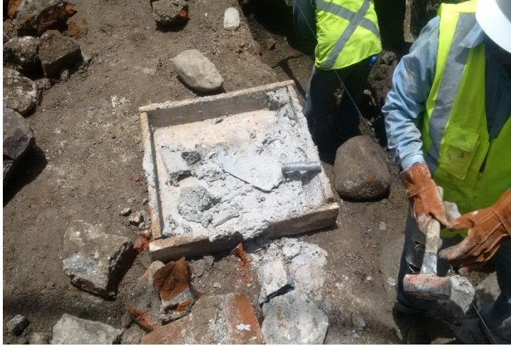
Imagen 147: Detalle de mortero base cal-arena utilizados en el mamposteo.
