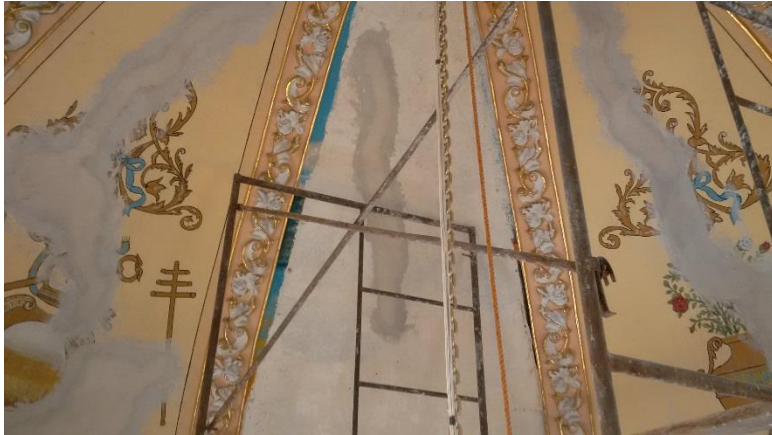
Imagen 158: Inyección de la cúpula principal del templo a través de mortero cemento-cal-arena.
