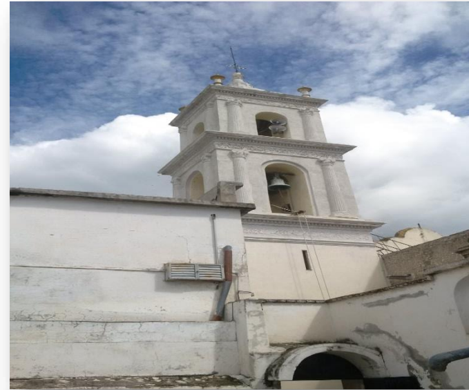
Imagen 133: Trabajos finales de integración de pintura base cal.
