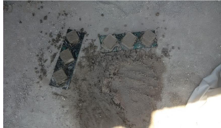
Imagen 163: Muestras de ensayos de mortero para laboratorio para pruebas de resistencia.
