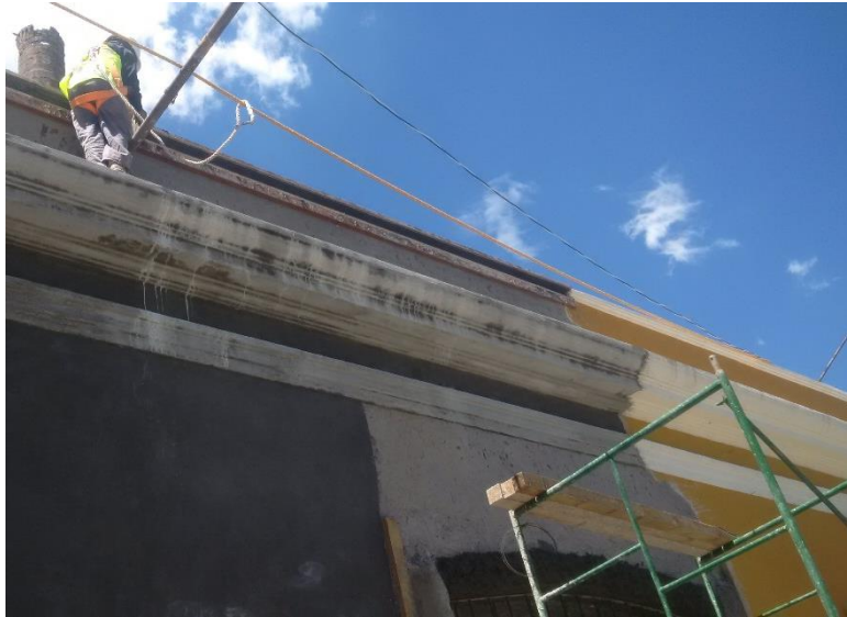
Imagen 152: Detalle de integración en cornisamento como elementos decorativos en la fachada original del siglo XIX.
