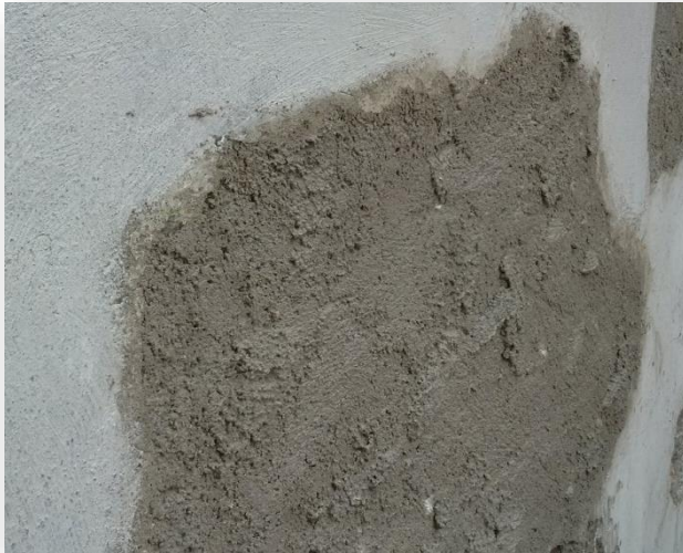
IMAGEN 25 Y 26: LA CAL YA SEA EN ESTUCO O EN MORTERO ES EL MATERIAL PRIMARIO EN LA RESTAURACIÓN.
