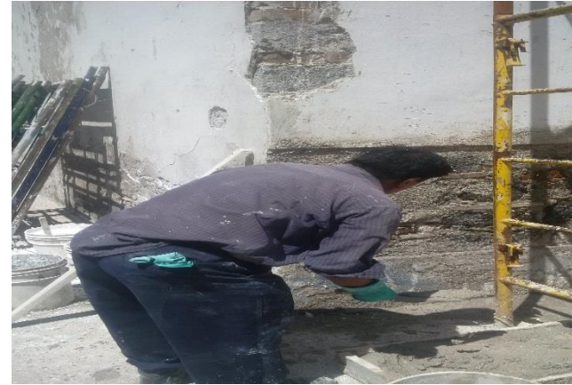
Imagen 142: Detalle de trabajo de integración de revoco o repello en muro limosnero.
