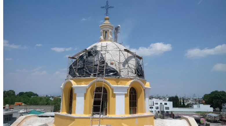
Imagen 159: Integración de recubrimiento de lechada a base de cal-arena y mucilago de nopal.
