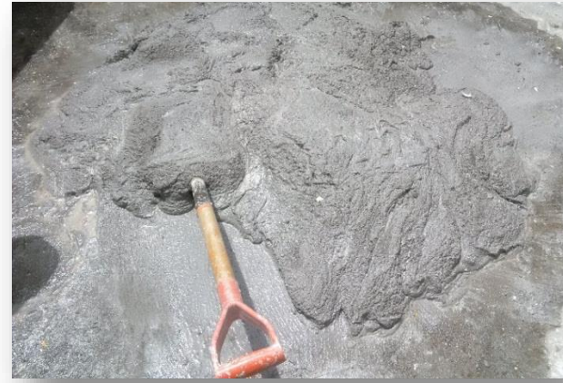
Imagen 129: Detalle de la homogeneidad del producto reduciendo granulometría y teniendo una pasta trabajable.
