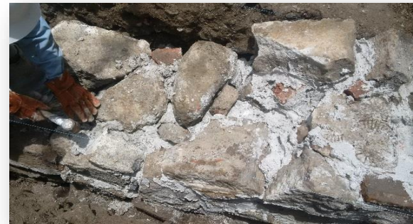
IMAGEN 27 Y 28: MORTERO BASE CAL-ARENA PARA JUNTEO DE MAMPOSTEO.
