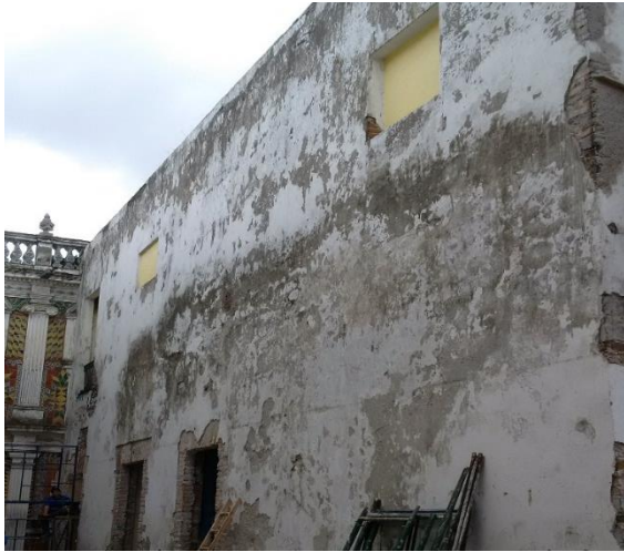
Imagen 138: Detalle del paredón que se harán los trabajos de restauración.
