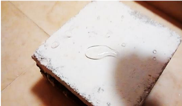
IMAGEN 35: ÁREA CON IMPERMEABILIZANTE REPELE EL AGUA Y NO DEJA QUE LA SUPERFICIE LA ABSORBA.
