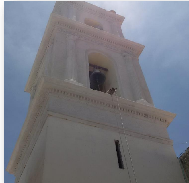
IMAGEN 37: FONDEO DE TORRE DE IGLESIA CATÓLICA EN CUANOPALAN CON APLICACIÓN DE UNA MANO CON PINTURA A LA CAL.
