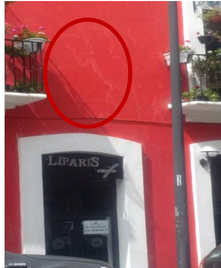
Vista del deterioro en aplanado. Inmueble ubicado en la calle 5 poniente N° 314 Fuente: J. Jiménez Ortega
