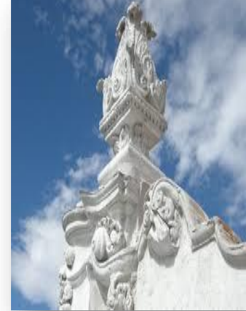
Imagen 120 -121: Detalles Ornamentales de Argamasa (cal-arena) de la Casa del Alfeñique del barroco Poblano del Siglo XVIII.
