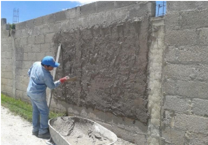
IMAGEN 31: APLICACIÓN DE MORTERO CAL – ARENA PARA REALIZAR MUESTRA DE RENDIMIENTOS.
