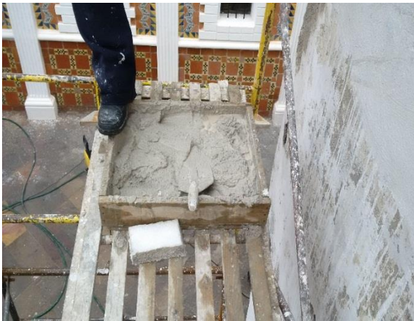
Imagen 140: Mortero a base de cal –arena que se utiliza en los trabajos de junteos y repellos.
