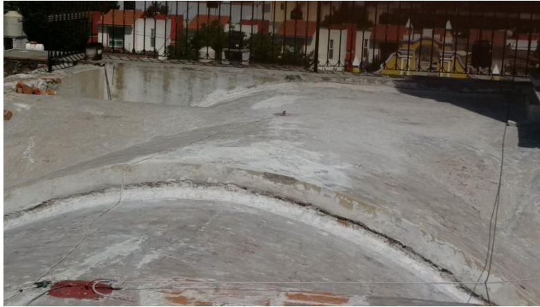
Imagen 162: Detalle de las bóvedas de cañón al integrar la lechada de cal –arena.
