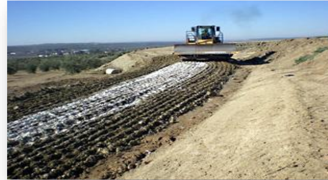
IMAGEN 24: LA CAL PARA ESTABILIZACIÓN DE SUELOS.
