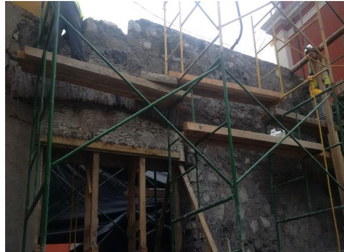
Imagen 150: Detalle de integración del muro hasta el nivel del cornisamento.
