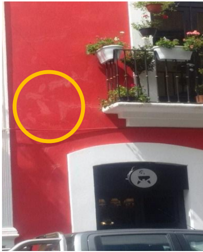
Vista del deterioro en aplanado. Inmueble ubicado en la calle 5 poniente N° 314 Fuente: J. Jiménez Ortega
