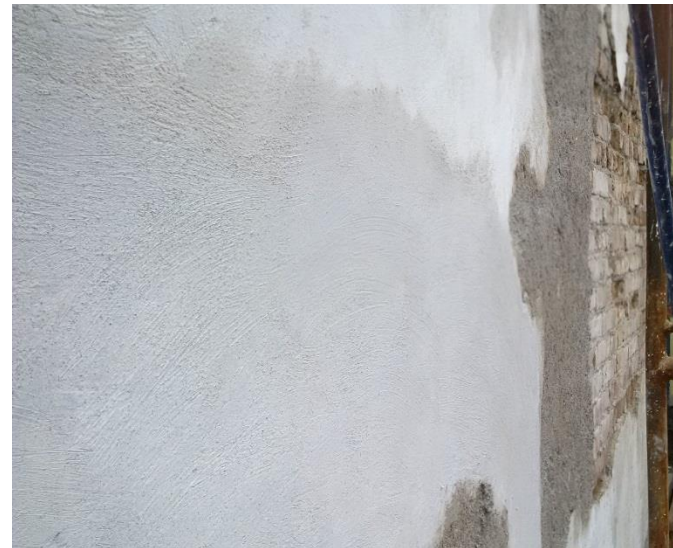
Imagen 144: Detalle de trabajo final de la integración del aplanado fino con pasta de cal-arena proporción 1:1.
