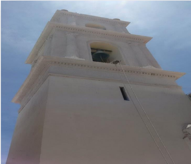
Imagen 132: Trabajos finales de integración de aplanados base cal-arena.
