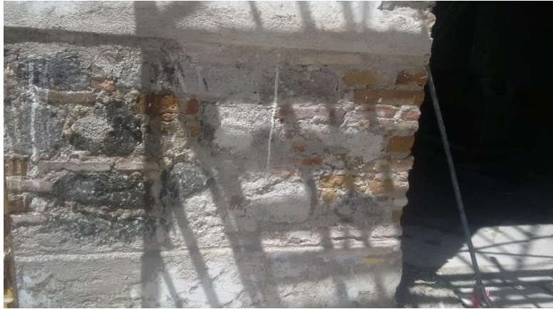
Imagen 141: Detalle de liberación de aplanado y tratamiento de muro de limosnero con limpieza para integración de revoco.
