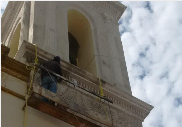
IMAGEN 28: INTEGRACIÓN Y CONSOLIDACIÓN DE ESTUCOS A BASE DE CAL-ARENA PARA MOLDURAS.
