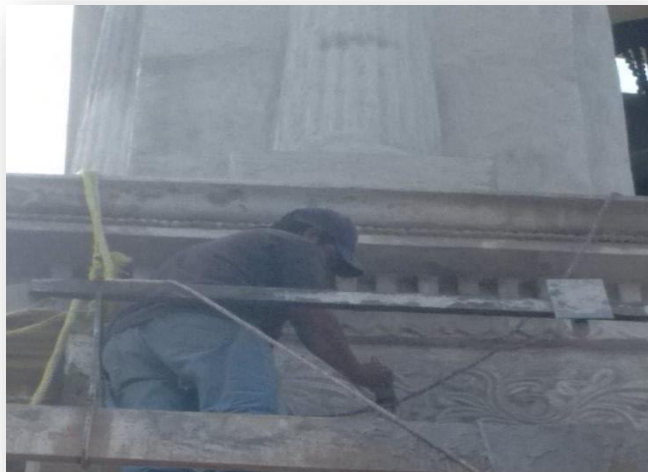
Imagen 130: Trabajos de integración de revocos y aplanados en las torres.
