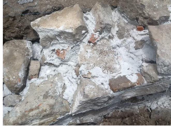
Imagen 148: Detalle de mortero base cal-arena utilizados en el mamposteo de los cimientos del muro utilizando piedra original del elemento.
