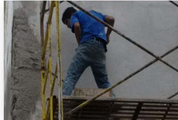
IMAGEN 29: INTEGRACIÓN DE APLANADOS A BASE DE CAL-CEMENTO.
