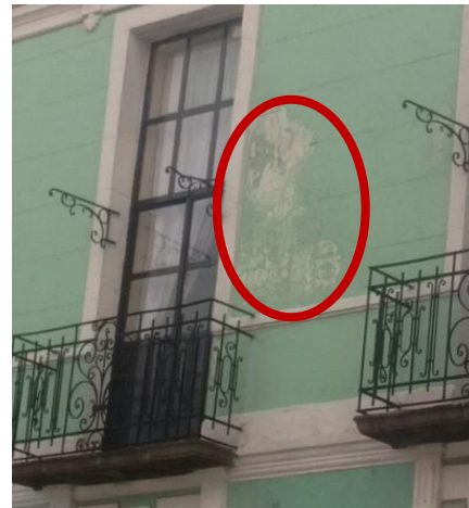
Vista del deterioro en aplanado. Inmueble ubicado en la calle 16 de Septiembre esquina 15 oriente Fuente: J. Jiménez Ortega
