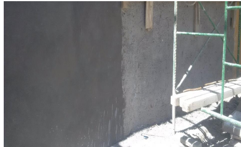
Imagen 151: Detalle de integración de revocos y aplanados finos realizados con mortero cal-arena.
