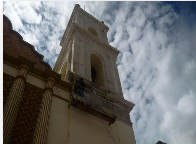
Imagen 131 Trabajos de integración de elementos vegetales decorativos en el friso de la torre.
