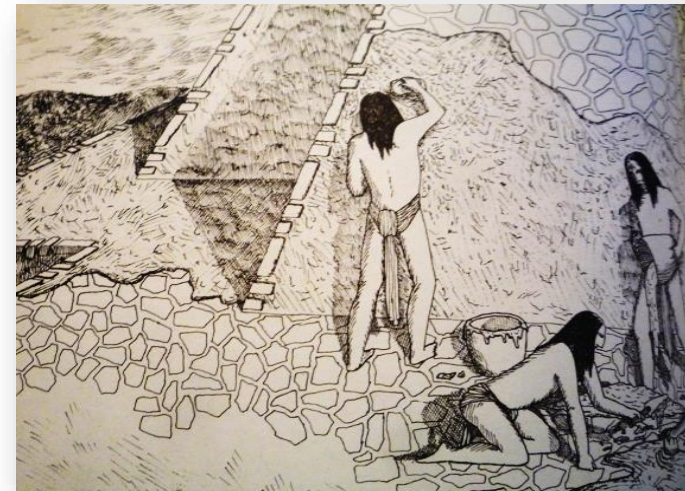
Imagen 75: Aplicación de Aplanado de CAL-ARENA en muro de mampostería.
