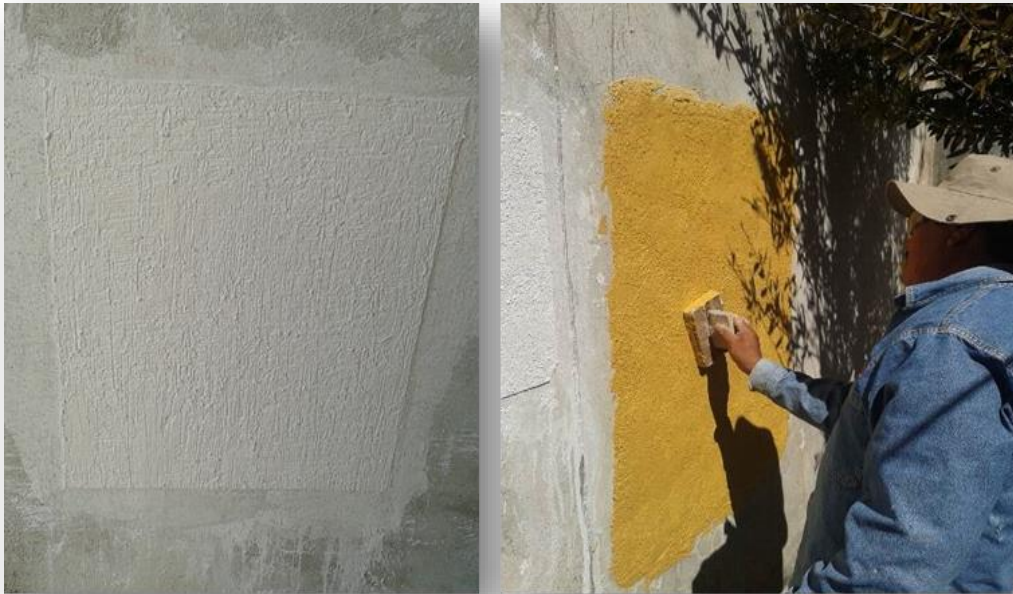
IMAGEN 38: APLICACIÓN DE PASTA A BASE DE CAL – MARMOLINA EN TONALIDAD BLANCO Y A COLOR; DONDE SE REALIZAN PRUEBAS DE COLOCACIÓN PARA DETERMINAR EL ACABADO FINAL.
