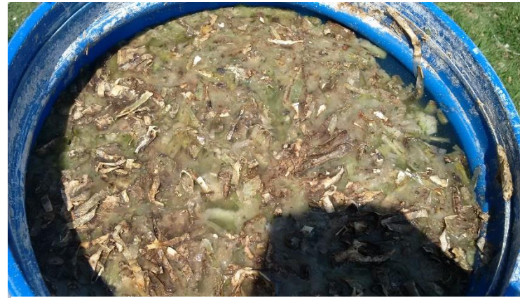
Imagen 165: Preparación de mucilago de nopal para implementación del mortero cal-arena. Central del templo.
