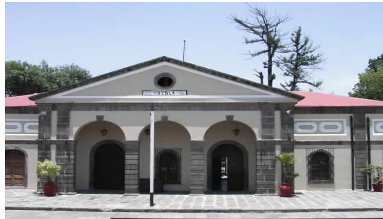
Imagen 110: Museo del Ferrocarril del siglo XIX en la ciudad de Puebla; Utilización de Aplanados originales a base de cal – arena.
