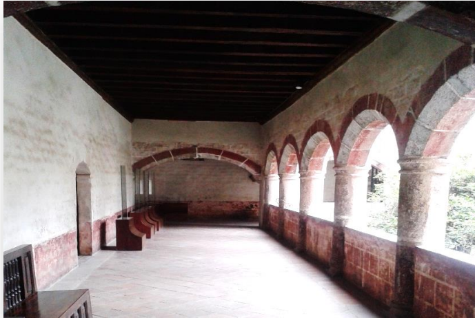
Imagen 115: Pasillo del claustro del ex convento de Huejotzingo en los muros y arcos se puede apreciar la pintura a la cal como el rojo oxido.
