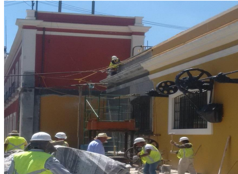
Imagen 153: Vista General de la Fachada principal ya con la integración de la fachada existente.
