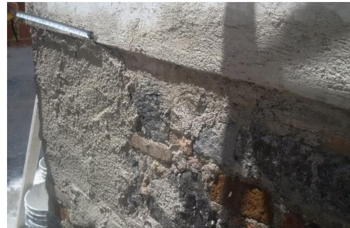
Imagen 141: Detalle de trabajo de integración de junteos y repellos en muros de limosnero con mortero cal-arena.
