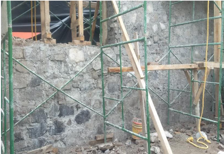
Imagen 149: Detalle de integración del muro de mampostería con la piedra existente del elemento anterior.
