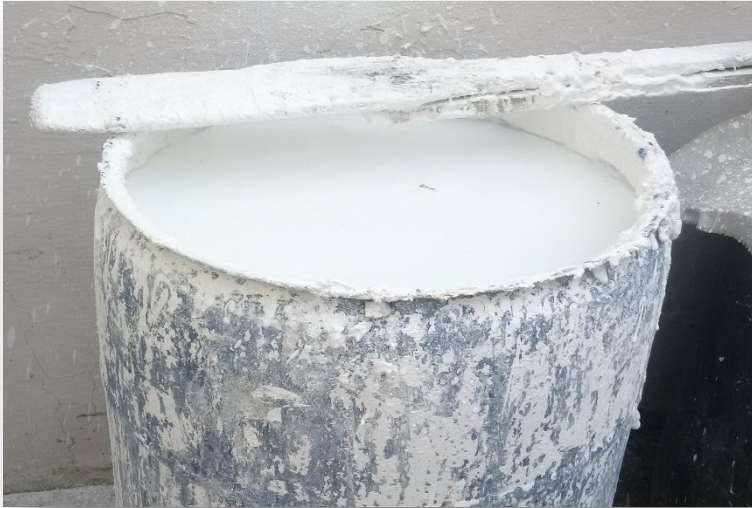
Imagen 126: Vista del procedimiento del apagado de la cal viva.
