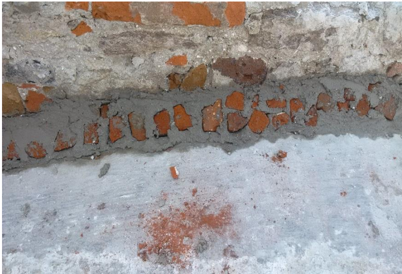
Imagen 160: Integración de chafanes a través de rajoleo de tabique y mortero cal-arena.
