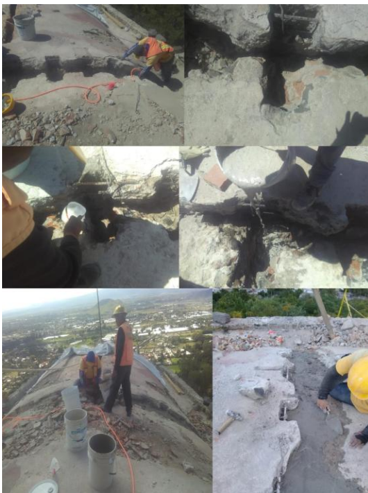
Imagen 121. Trabajos de intervención en el cañón corrido (8extradós) de la Capilla de San Miguel. Fuente: Mtro. Gregorio. Septiembre 2018.
