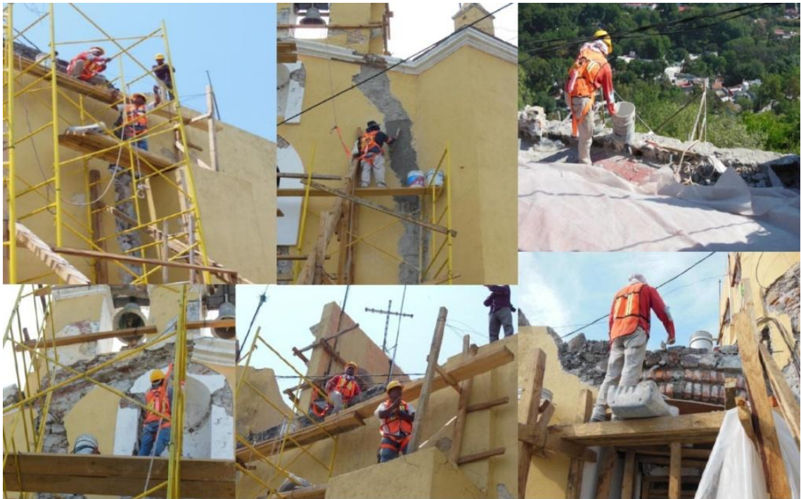
Imagen 120. Collage de trabajos de intervención efectuados en la capilla de San Miguel. Abril-junio 2018. Fuente: Arq. Graciela Walls
