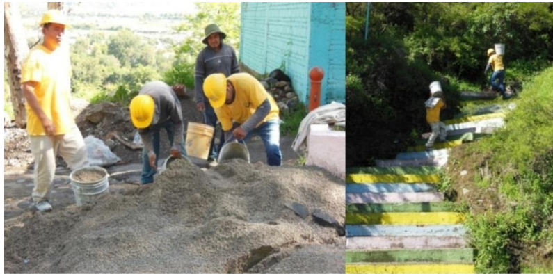
Imagen 119. Acarreo de materiales a hombro para los trabajos de restauración en la capilla de San Miguel. Fuente: Graciela Walls. Junio 2018
