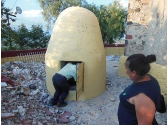
Figura 157. Sra. Rosalba y Sr. Isaías verificando el estado del pozo de la Capilla de San Miguel. Fuente: Graciela Walls septiembre 2018.
