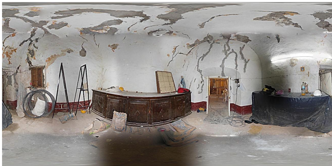
Imagen 29. Vista 360 de la Sacristía, se aprecia la puerta que comunica de la sacristía al ábside de la capilla, en el extremo derecho aparece la puerta que comunica la sacristía con el anexo. Fuente: Graciela Walls. Octubre 2018.
