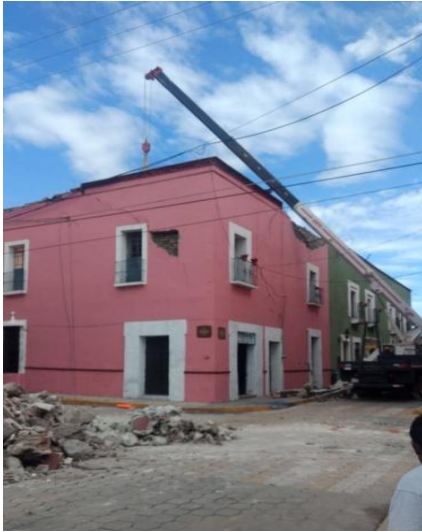
Imagen 8. Inmueble ubicado en 6 Poniente esquina Av. Libertad a punto de ser demolido. Fuente: Graciela Walls. Septiembre 2017
