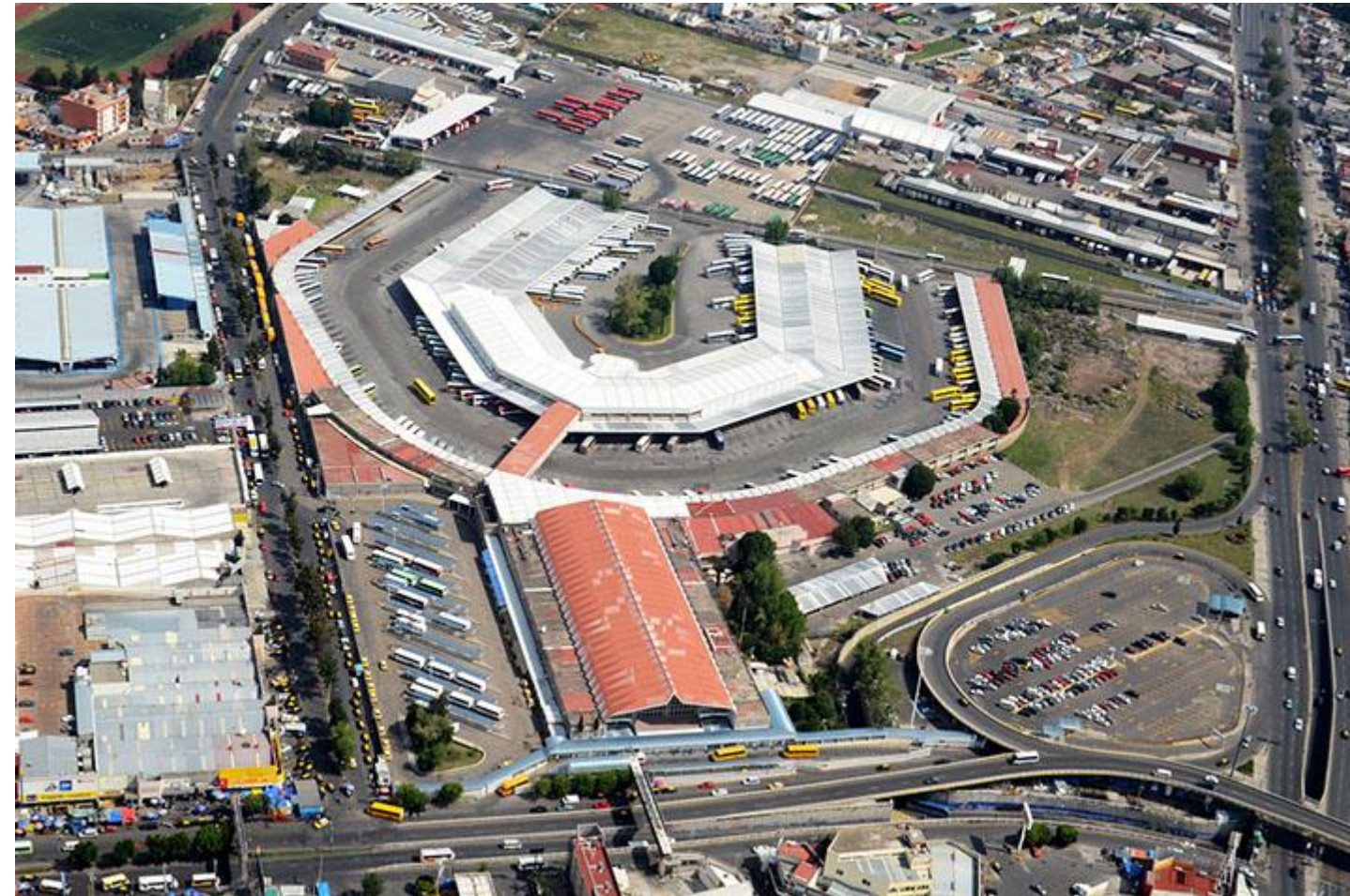
Imagen 51: Central de autobuses CAPU vista aérea . Fuente: Google. (s.f.). [Google imágenes]. Recuperado el 23 de febrero, 2022, de https://www.google.com/search?q=central+de+autobuses+capu&sxsrf=APq-WBuD08wxAM9OrPLVfa7AbHsA0we-Qg:1645603046966&source=lnms&tbn=isch&sa=X&ved=2ahUKEwjxxLilrZX2AhXUmGoFHdXCBCQQ_AUoAnoECAIQBA&biw=1366&bih=568&dpr=1#imgsrc=dkl0pocjVrrSdM
