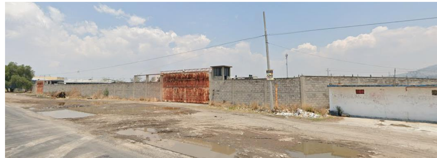
Imagen 31: Panorámica del frente del predio ubicando postes de infraestructura eléctrica. Fuente: Elaboración propia
