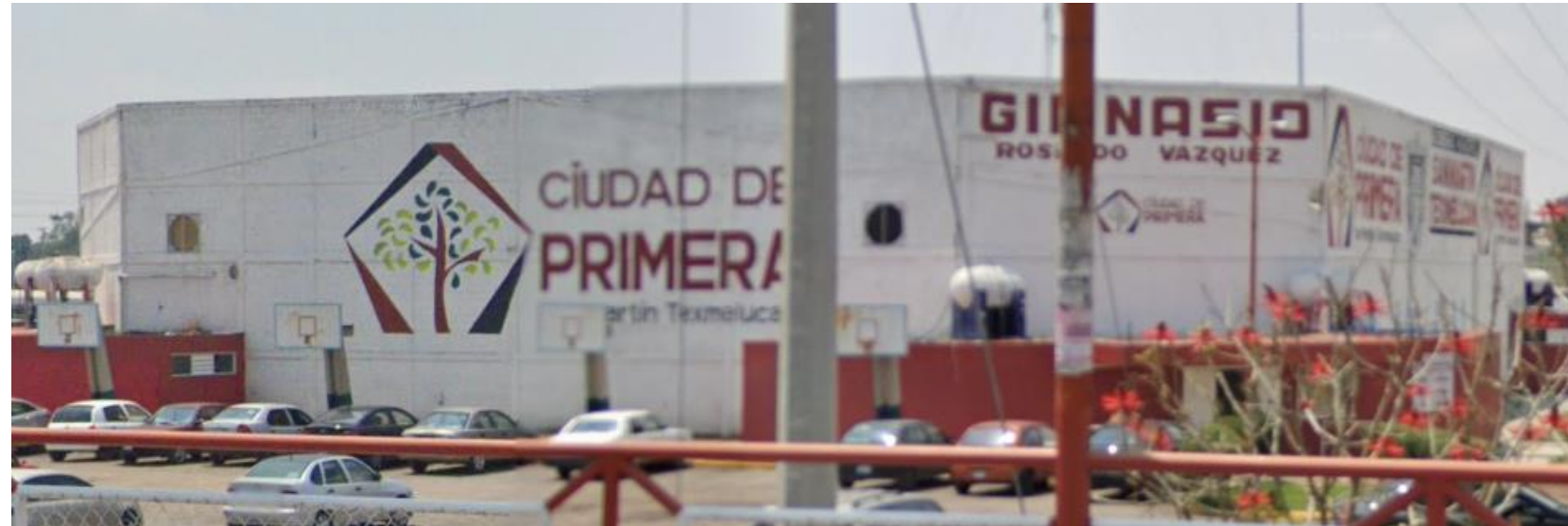
Imagen 47: Auditorio Deportivo San Damián, San Martín Texmelucan, Pue. Fuente: Fotografía propia.
