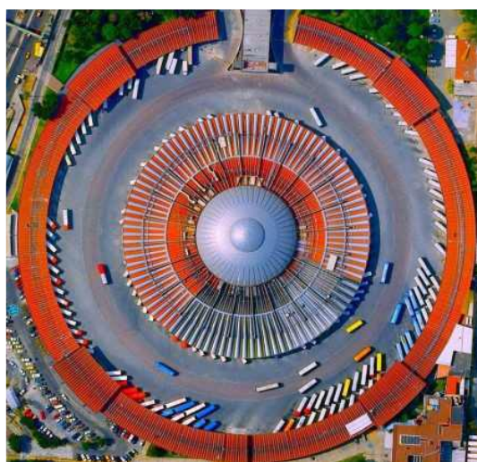
Imagen 55: Vista aérea Tapo. Fuente: Quigley, A. (2021). TAPO (Fotografía). MéxicoDestinos.com. https://www.mexicodestinos.com/blog/tapo-todo-acerca-de-la-terminal-de-autobuses/
