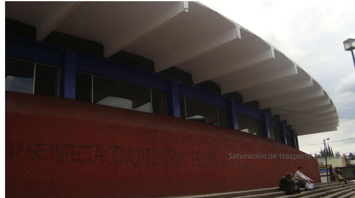
Fachada lateral. de la actual central de autobuses del estado de Tlaxcala
