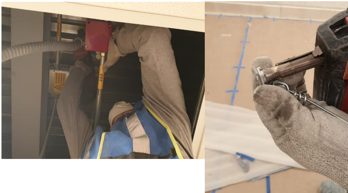
Imagen 4.16 Instalación y muestra de anclaje para colganteo Jiménez J. 2022
