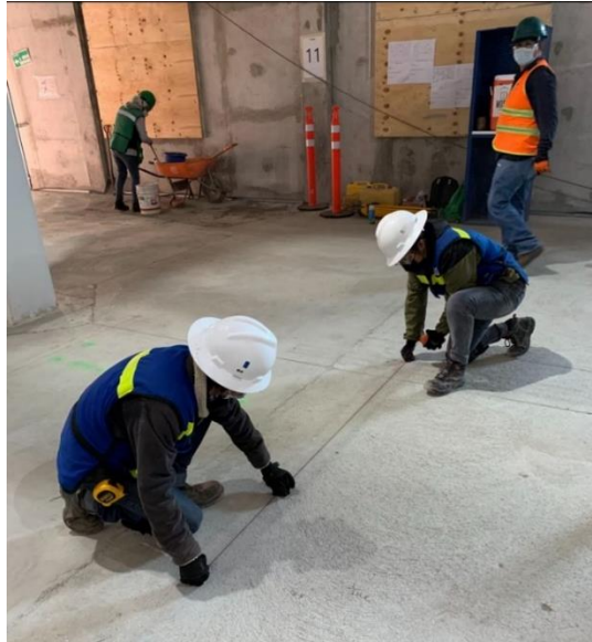
Imagen 4.5 Marcaje de paños y ejes con tira-linea Jiménez J. 2022
