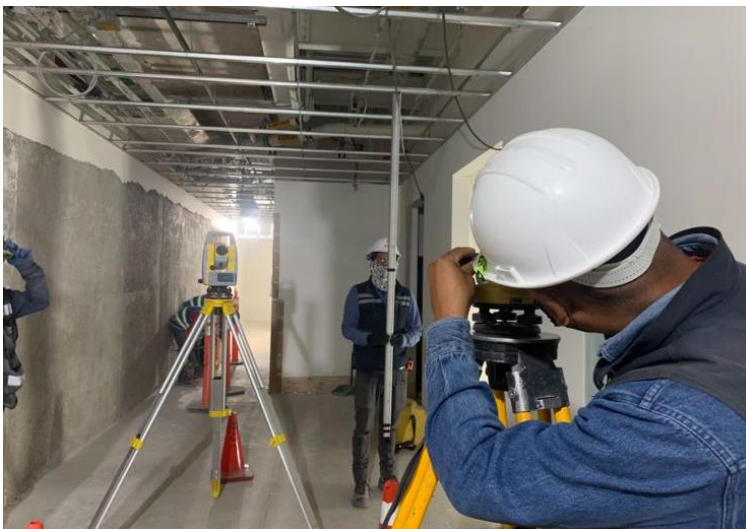
Imagen 5.7 Verificación topográfica de nivel de referencia para la instalación de plafones
