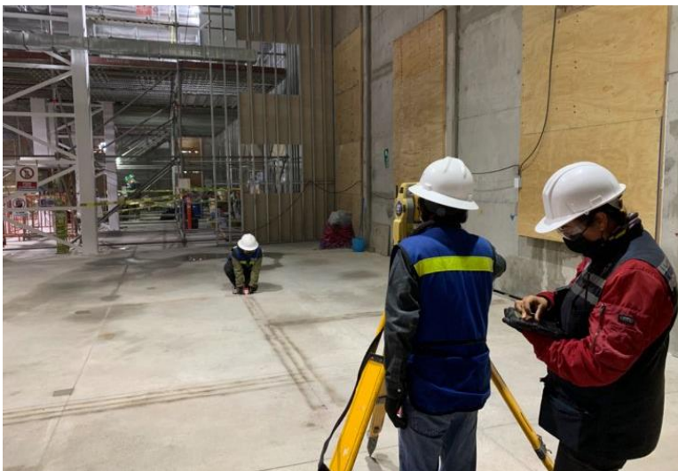
Imagen 4.6 Revisión de ejes y paños con supervisión Jiménez J. 2022
