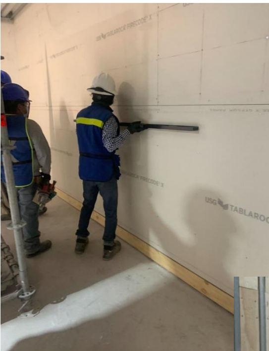
Imagen 5.5 Revisión de alineamiento de panel de yeso
