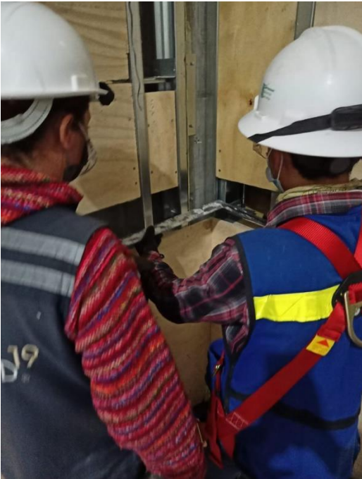
Imagen 1.6 y 1.7 Revisión de dimensiones y escuadras con técnicas clásicas Jiménez J. 2022
