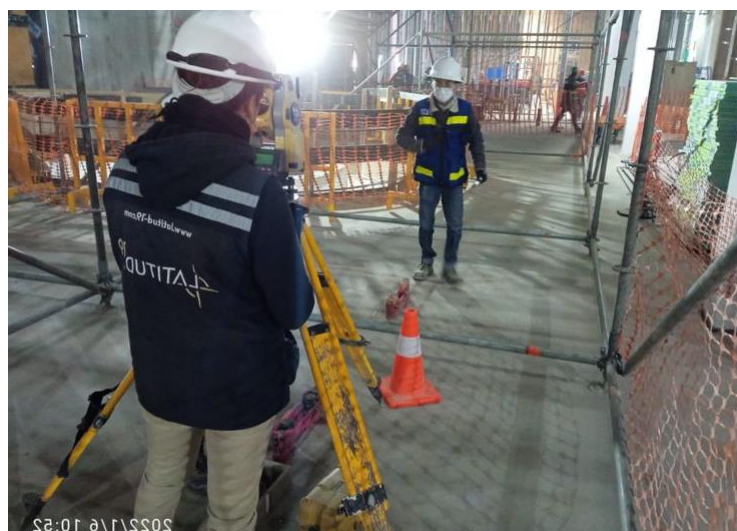
Imagen 4.11 Verificación de puntos con supervisión Jiménez J. 2022
