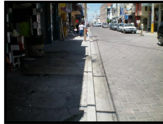
Foto 2.- Calle 5 pte. Área peatonal en mal estado. Arroyo vehicular en óptimas condiciones. Fuente: Fotos del Autor.
