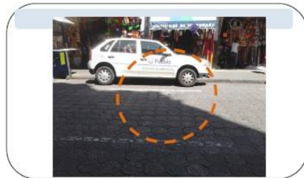
HUNDIMIENTOS POR TOMA O DESCARGA DETERIORADA UBICACIÓN: 8 PONIENTE CASI ESQUINA 3 NORTE LADO NORTE.
