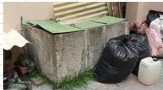
PILETA ANTIGUA CANTERA NATURAL REMACHES DE FIERRO
