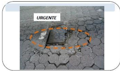
HUNDIMIENTO TAPA SOAPAP UBICACIÓN: 9 NORTE Y 8 PONIENTE
