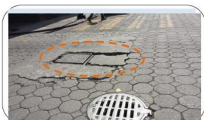
HUNDIMIENTO EN REGISTRO AGUA POTABLE UBICACIÓN: 9 SUR Y 3 PONIENTE.
