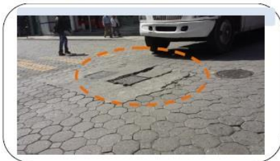
HUNDIMIENTO EN REGISTRO AGUA POTABLE UBICACIÓN: 9 SUR Y 3 PONIENTE.
