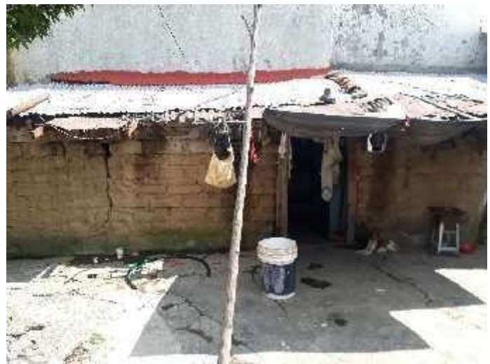
Imagen 39. Fachada del inmueble con un marco de puerta de concreto. Foto por el autor
