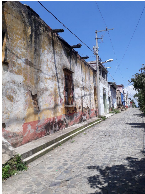
Imagen 32. Fachada del inmueble. Foto por Hernández, 2018.
