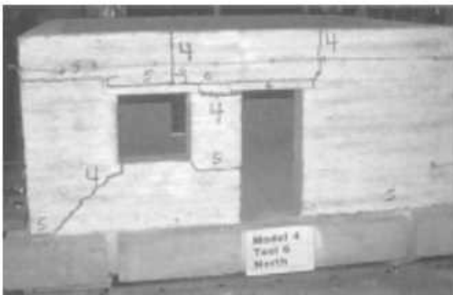
Imagen 64. (Minke, 2001) Grietas por simulación de sismo.
