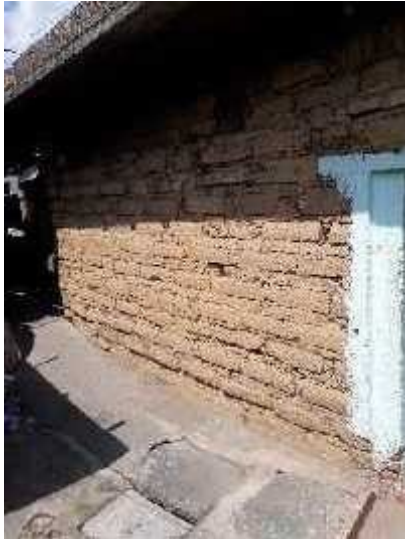
Imagen 51. Parte de la fachada, se aprecia un marco de concreto. Foto por el autor
