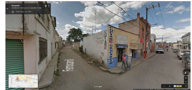
Ilustración 35 Estrechamiento del tramo B en la segunda manzana, Google Maps.
