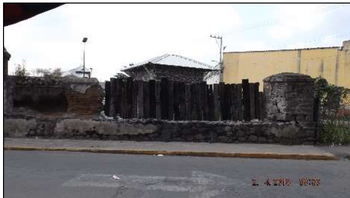
Ilustración 53 Barda de piedra, atrás oficina Willow. Tramo C.
