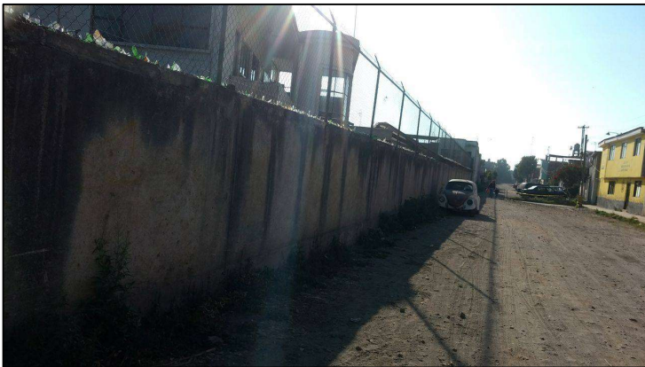
Ilustración 57 CECEM por fachada trasera en el tramo D.
