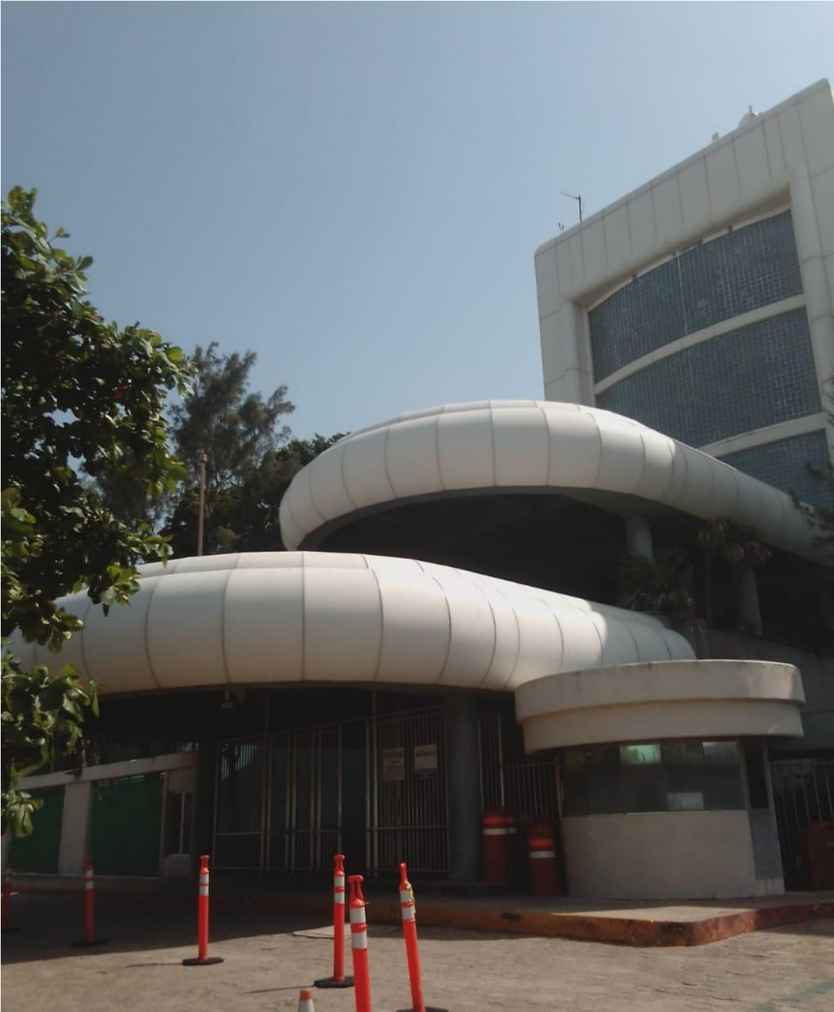
Edificio Inteligente de Pemex Petroquímica, vista desde la calle Jacarandas, Fotografía tomada por Luis Antonio Armas Alor.
