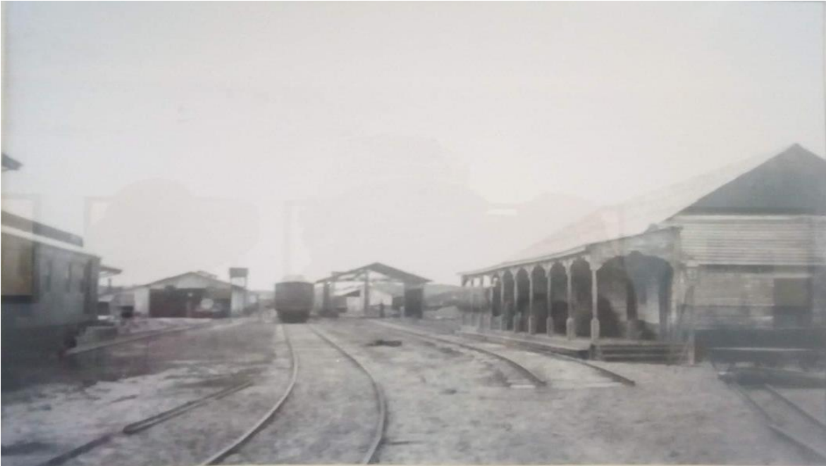
Estacion Ferroviaria de Coatzacoalcos 2; obtenida de la Exposición fotográfica, "Un Sueño Interoceánico: Viaje por el istmo de Tehuantepec" que se presentó en el Museo Nacional de los Ferrocarriles Mexicanos donde se mostró el álbum "Las obras del Puerto de Veracruz y el Istmo de Tehuantepec desde el Atlántico al Pacífico, del año 1897" capturadas por el fotógrafo Carlos de Landa y Escandón de la colección Secretaría de Cultura/CNPPCF/MNFM/CEDIF.
