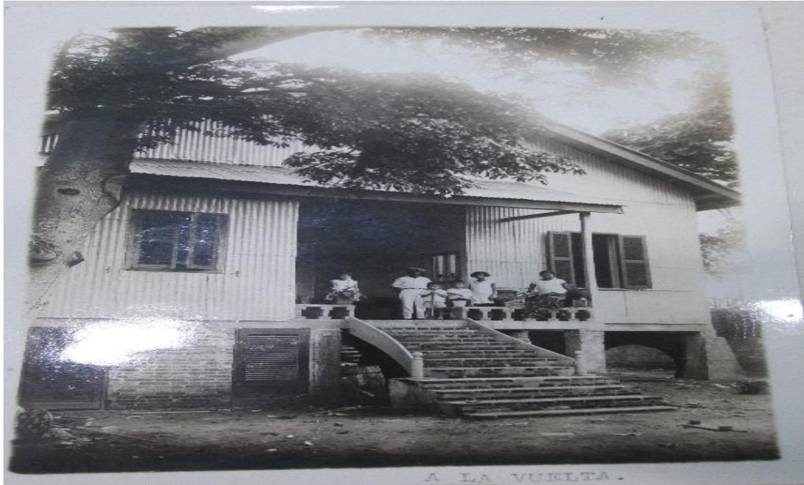
Fotografía de la Antigua Oficina de Correos y Telégrafos, tomada a la vuelta de la misma, ubicada en la calle Malpica, cercana al río, fotos obtenidas del acervo de la Secretaría de Comunicaciones y Obras Públicas, localizada en el AGN, con los siguientes datos para consulta: 42027/11/Reg.208629.referenciaMX09017AGN0000025899277
