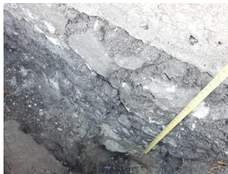
Foto 53. Cimentación a base de piedra a 80 cms de profundidad. Fuente: MAECPE. 2019.
