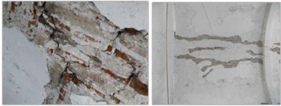
Bóveda de cañon corrido Sistema mixto a base de piedra y tabique
