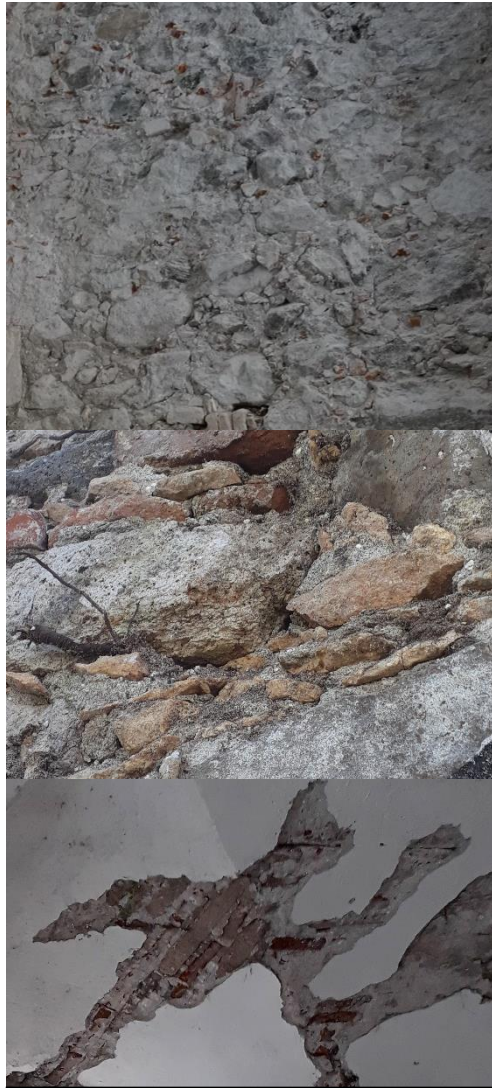
Foto 54. Mampuestos mixtos de piedra y tabique. Fuente: Guadalupe Vera. 2019. Foto 55. Contrafuertes de piedra. Foto 56. Bóveda de cañón corrido de piedra y ladrillo. Fuente: MAECPE. 2019.
