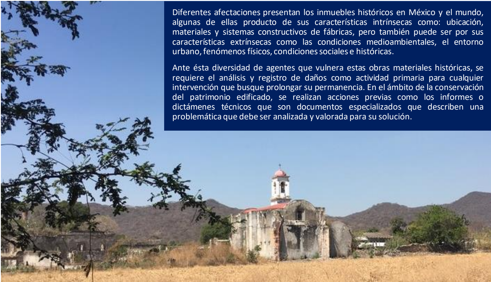
Fachada este del Templo de San Lucas. Fuente: Norma Solís. 2019.
