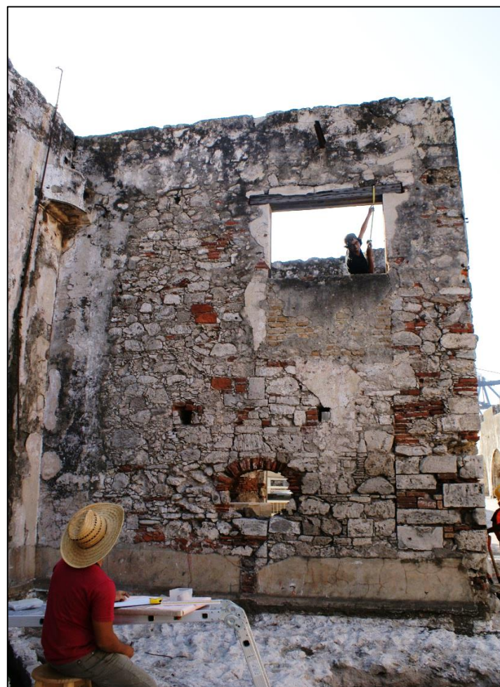
Fig.156 Ejecución de levantamientos a detalle Foto: Arqlga. Judith Hernández Aranda. San Juan de Ulúa Veracruz. 2009
