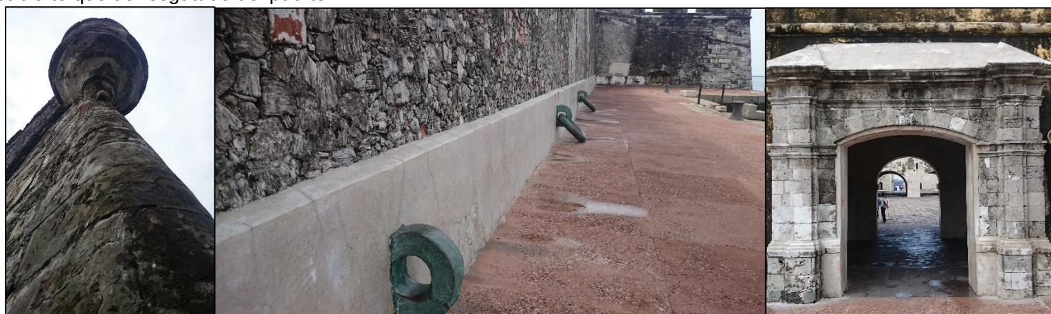
Fig. 112. De izquierda a derecha, vista del medio gariton, muro de argollas y acceso a la plaza de armas. Foto. Angelina del C. Gonzalez Díaz. Veracruz
