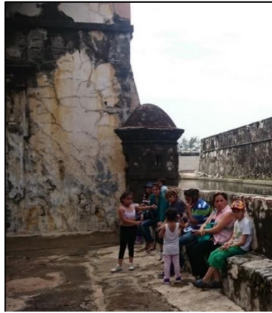
Fig. 35 Revellín de San José, en el Fuerte de San Juan de Ulúa. Foto: Arq. Angelina del C. Gonzalez Díaz. Ver. Mex.2015
