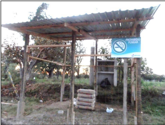
Figura 51.-Almacén temporal para material de construcción. (Foto tomada en sitio, 2013)
