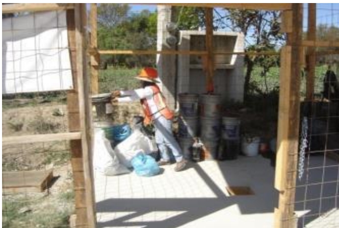
Figura 44:- Manejo de residuos peligrosos. (Foto tomada en sitio, 2013)
