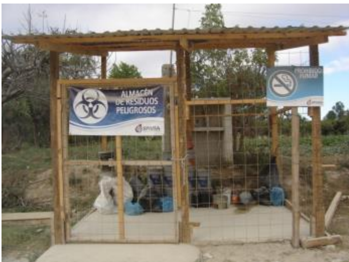
Figura 50.- Almacén de residuos peligrosos (Foto tomada en sitio, 2013)
