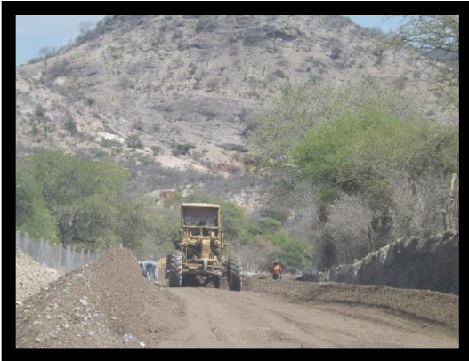
Imagen 5. La carretera siempre ha sido símbolo de progreso y en el 2014 se inició con la pavimentación de la entrada a Guadalupe Alchipini.
