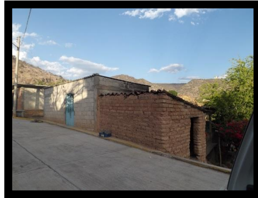
Imagen 6. Las casas aun guardan estructuras hechas de tabiques de adobe.
