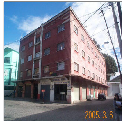
Edificio No. 320, sobre la Av. 22 pte., Art Nouveau Fuente: M.A.G.F., Febrero 2014
