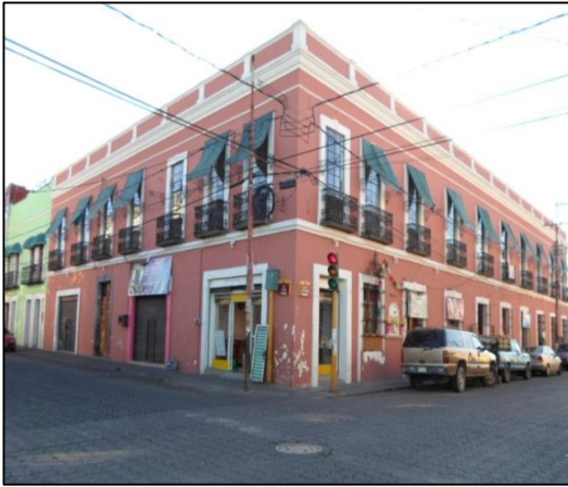
Edificio No. 2002, sobre la calle 3 Norte, s. XIX-XX Fuente: M.A.G.F., Febrero 2014
