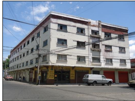
Fotografía de la fachada principal del edificio No. 112 conocido como "Edificio Rojo". Fuente: M.A.G.F.
