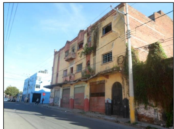
Av. 22 Poniente No.320. Fachada principal sobre la Av. 22 Poniente. Fuente: M.A.G.F., Febrero 2014.
