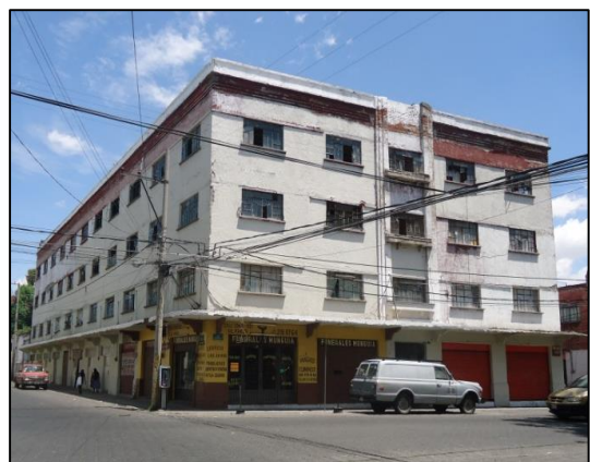
Fotografía de la fachada principal del edificio No. 112 en Marzo del 2014. Fuente: Abigail Gordillo
