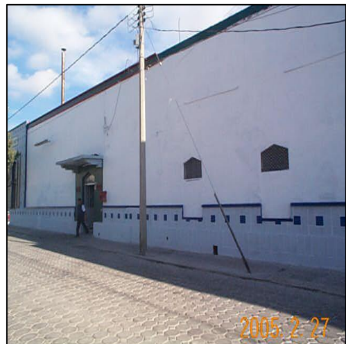
Baños públicos “Neptuno” sobre la Av. 22 poniente No. 114, Barrio de San Antonio Fuente: M.A.G.F.
