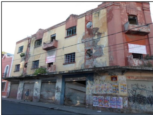
Fachada lateral sobre la calle 5 Norte
