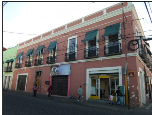
Fachada principal sobre la calle 3 Norte Fuente: M.A.G.F., Febrero 2014.
