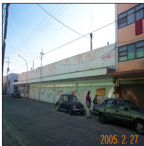
Calle 3 Norte entre 20-22 poniente. Fuente: M.A.G.F.
