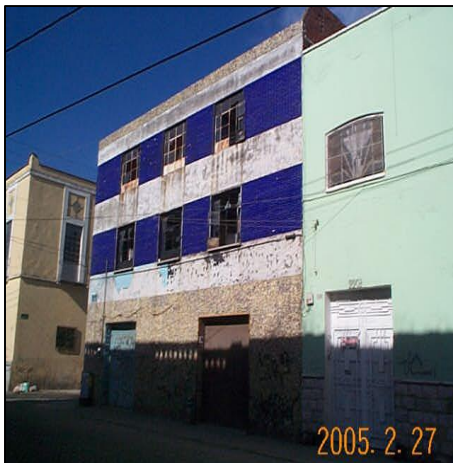
Av. 22 Poniente No.102. Fachada lateral Fuente: M.A.G.F., Febrero 2005
