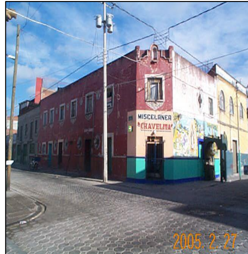
Vivienda de uso mixto sobre la Av. 22 poniente No.106. Barrio de San Antonio Fuente: M.A.G.F.
