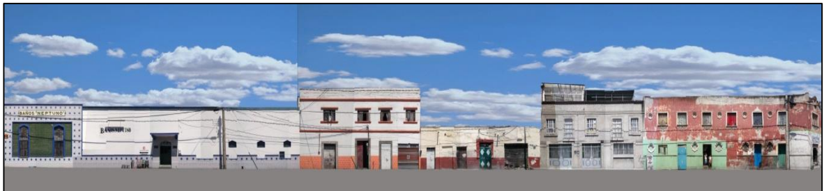
Av. 22 Poniente entre 3 Norte y privada de la 22 Poniente. (Vista de la Cera Norte con importantes edificios multifamiliares que presentan deterioros en fachadas). Perfil 6
