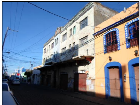
Vista general de la Calle 3 norte No. 2005.
