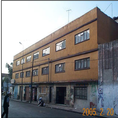
Av. 28 Pte. No.2215. Fachada principal Fuente: M.A.G.F., Febrero 2005
