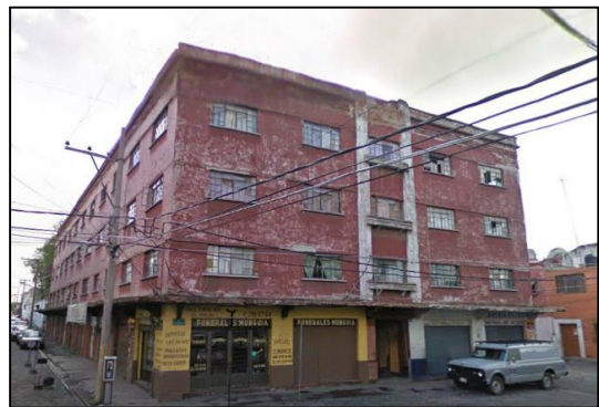
Fotografía de la fachada principal del edificio No. 112 por google earth en Febrero de 2012.
