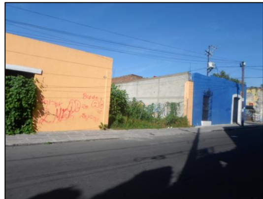
Vista general de la Av. 22 poniente No. 317
