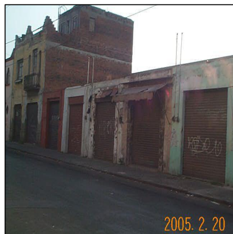
Calle 5 Norte entre 20- 22 poniente. Fuente: M.A.G.F.
