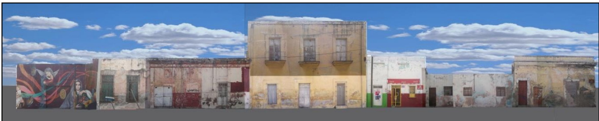
Privada de la 22 Poniente entre Av. 24 Poniente y Av. 22 Poniente. (Vista al oriente, se aprecian viviendas con alto grado de deterioro y murales de grafiti en fachada). Perfil 4
