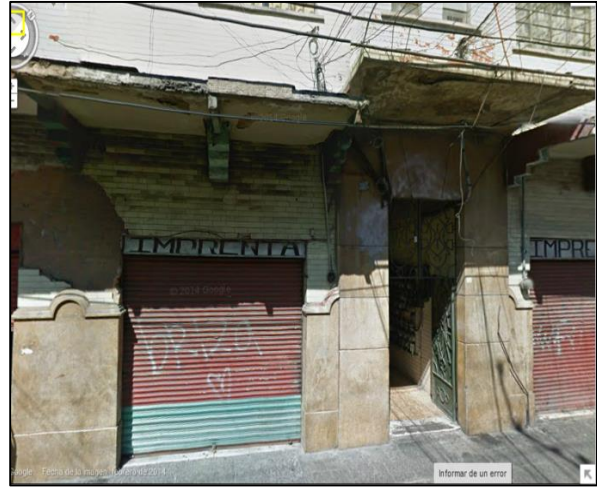
Imagen vista por google earth. Latitud 19°03'18.13"N Longitud 98°11'39.25"O alto ojo 2.16 m. Fecha 02/Enero/2012.
