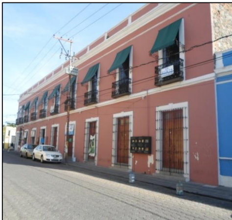
Fachada lateral sobre la Av. 20 pte. Fuente: M.A.G.F., Febrero 2014.
