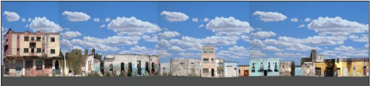
Av. 22 Poniente entre 5 Norte y 3 Norte. ( Vista de la Cera Norte con alto grado de deterioro en sus edificios mas representativos). Perfil 5
