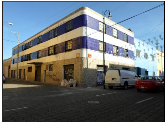
Vista general de la Av. 22 poniente No. 102
