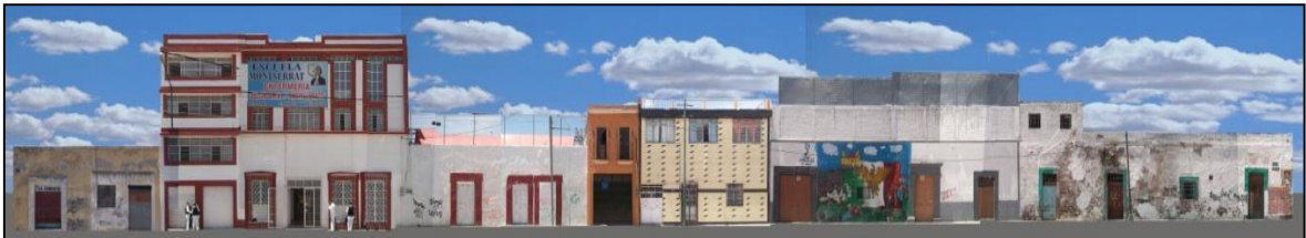
Privada de la 24 Poniente entre calle 3 Norte y Priv. 22 Poniente. (Vista al sur, se aprecia la fachada de la Escuela de Enfermería Montserrat y viviendas con visibles deterioros en sus fachadas). Perfil 2
