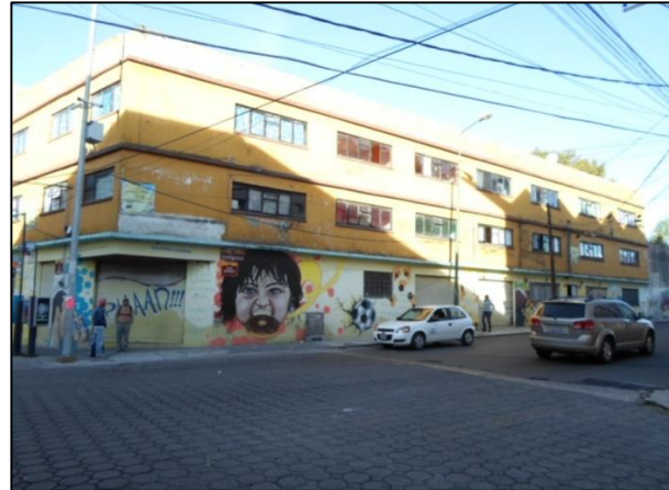
Av. 28 Pte. No.2215. Fachada principal Fuente: M.A.G.F., Febrero 2014
