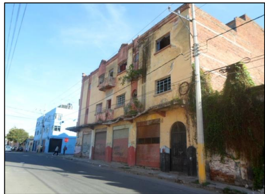
Fachada principal sobre Av. 22 Poniente
