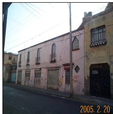
Calle 5 Norte entre 20- 22 poniente. Fuente: M.A.G.F.
