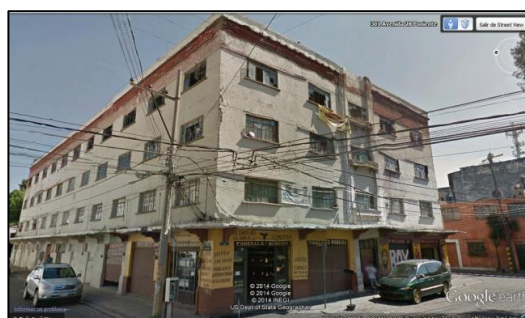
Imagen vista por google earth. Latitud 19° 03' 18.08"N Longitud 98°11'39.20"O alto ojo 2.16 m. Fecha 02/Enero/2014.
