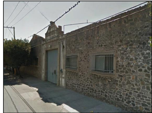
Fabrica de hilados y tejidos "La Angelica", Av. 28 poniente No. 507, Barrio del Refugio. Fuente: Google Earth Febrero 2014
