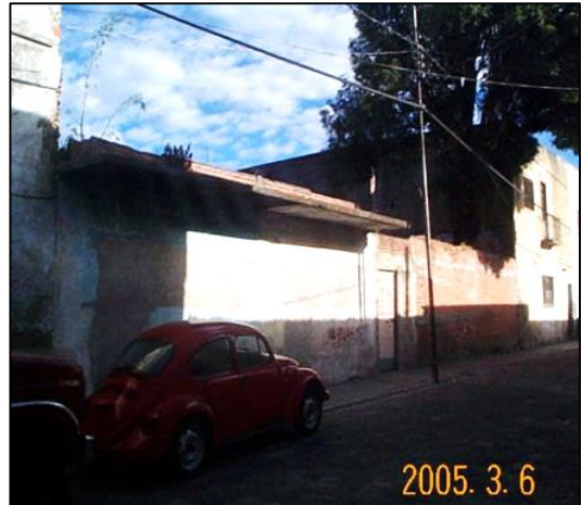
Inmueble No.2007, sobre la calle Melchor Ocampo, se encontraba en estado ruinoso solo quedaba una barda que delimita el acceso. Fuente: M.A.G.F., Marzo 2005
