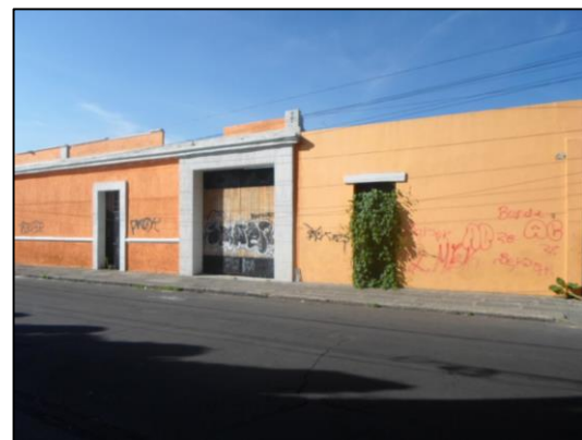
Vista general de la Av. 22 poniente No. 315
