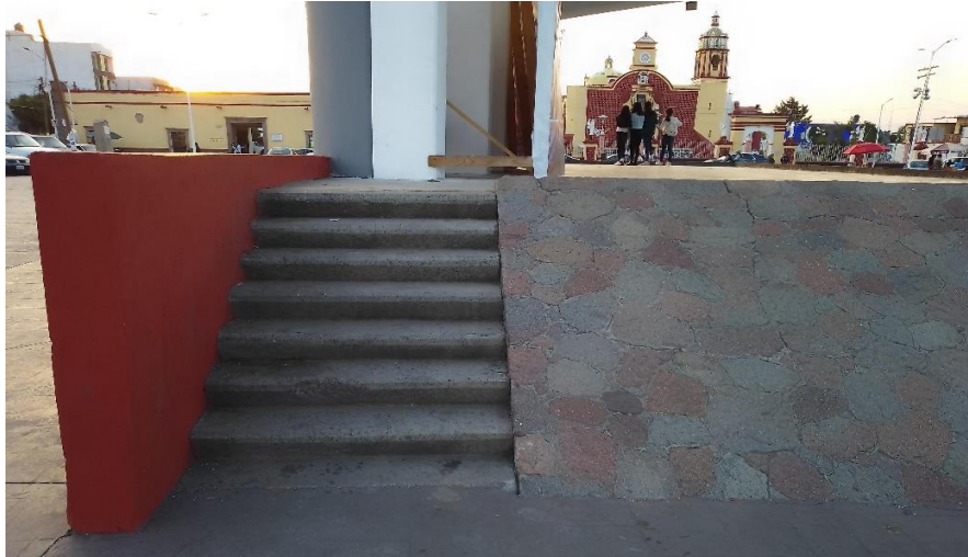
Ilustración 42 Lado lateral oriente del inmueble de la explanada
