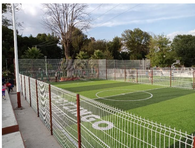
Ilustración 55 Rehabilitación de la cancha de futbol
