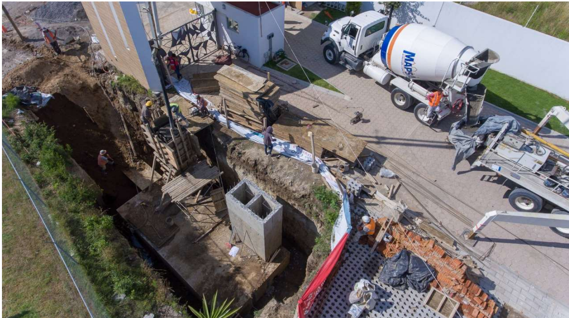
Ilustración 10: Construcción de planta de tratamiento en acceso de fraccionamiento en San Andrés Cholula. Residencial Loto. Fuente: Elaboración propia.
