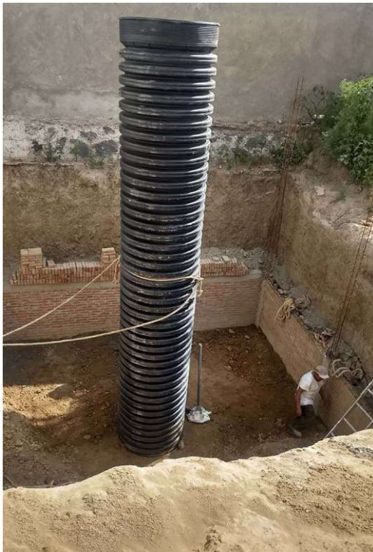
Ilustración 8 Construcción de un pozo de infiltración. y Diagrama de pozo de infiltración. Fuente: Elaboración propia
