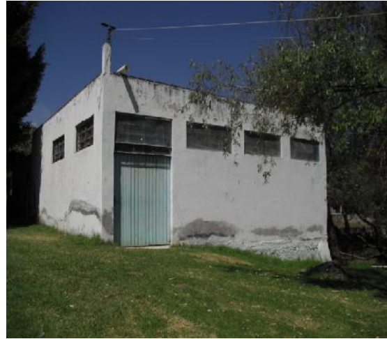
SALÓN DE JUNTAS
