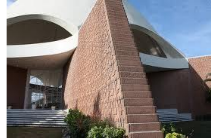
Figura 3.15. Detalle de muros de carga.
