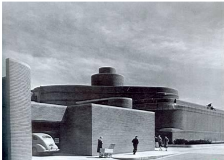
Figura 3.4.-Oficinas de administración de S. C. Johnson (Wisconsin)
