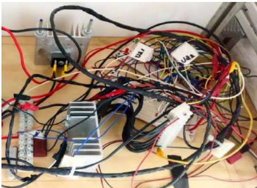
Figura 4.14 Circuito de potencia implementado en el primer prototipo
