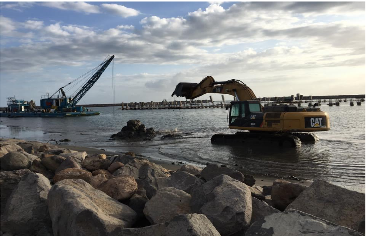
Removiendo rocas en el área de dragado, zonas de menor calado.
