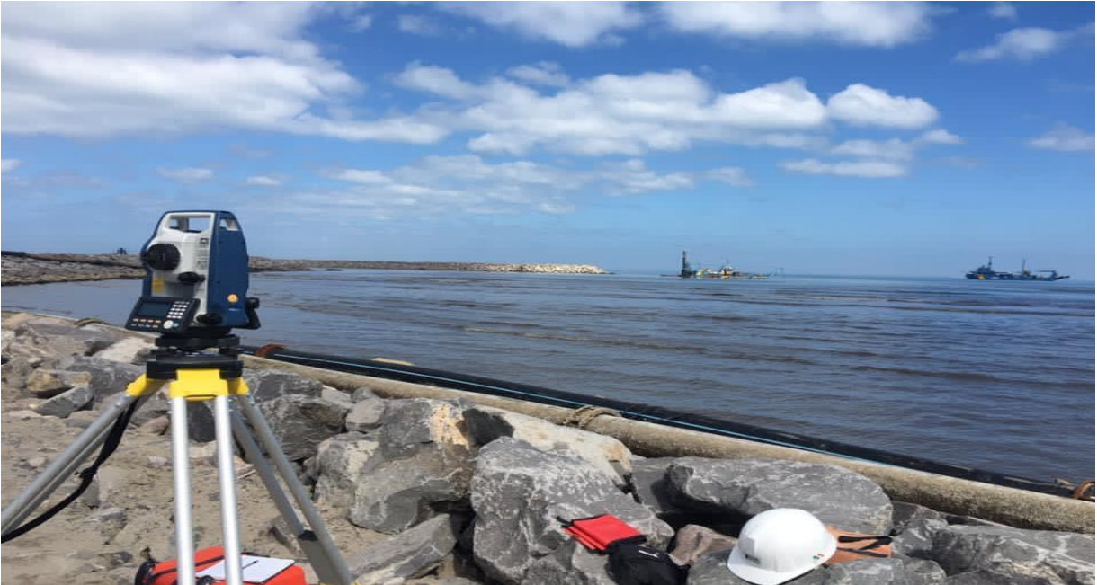
Replanteo de puntos para colocación de boyas y dragar lo indicado para canal navegación que conecta a muelle de escollera.
