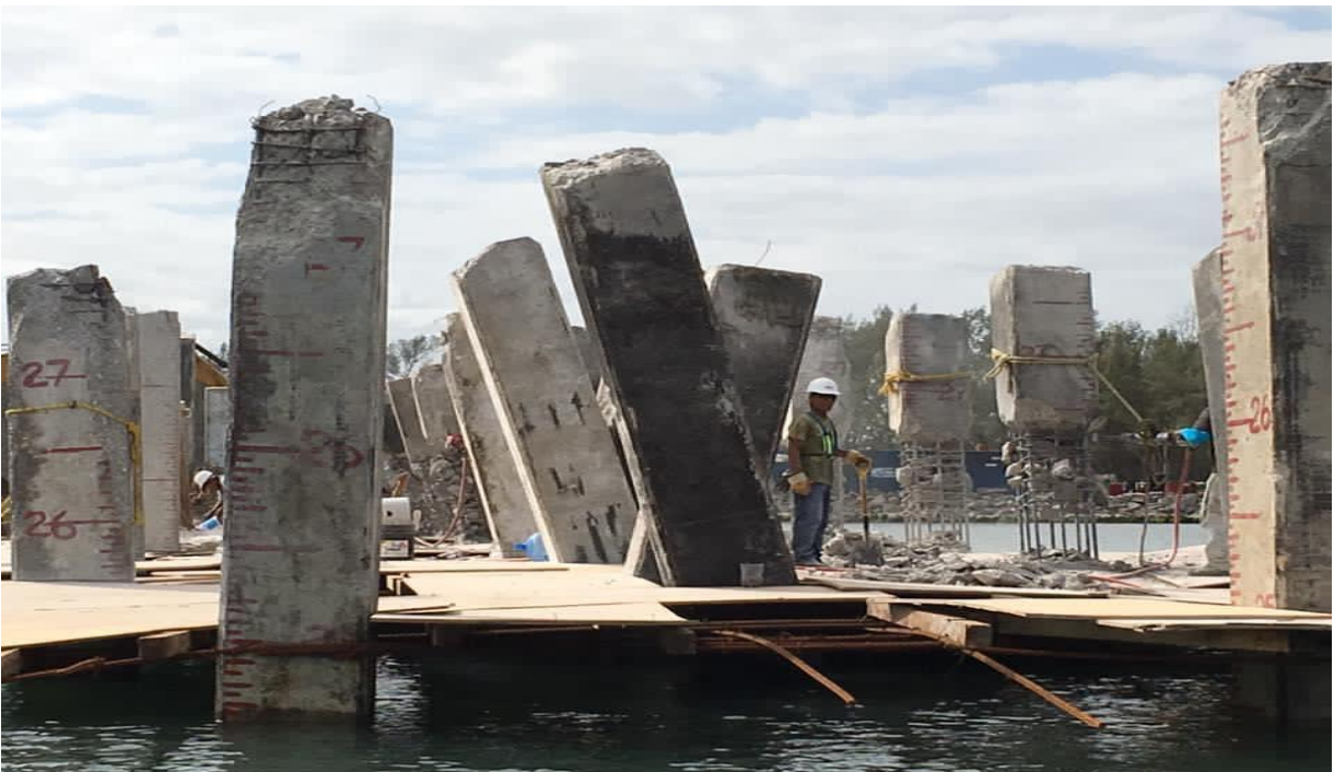
Pilotes para construcción de embarcadero (muelle).
