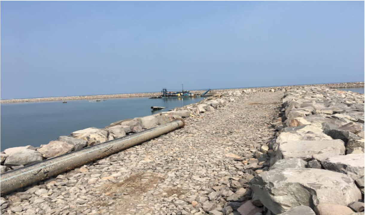
Vista de escollera en general, con barco de draga al fondo de imagen.
