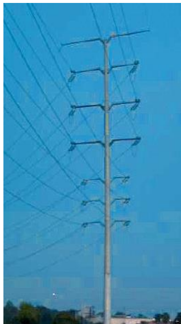
Figura 1.7 Poste troncocónico de cuatro circuitos (2 de 230 kV y 2 de 69 kV). (Fuente: Manual de Líneas de Transmisión Aéreas)
