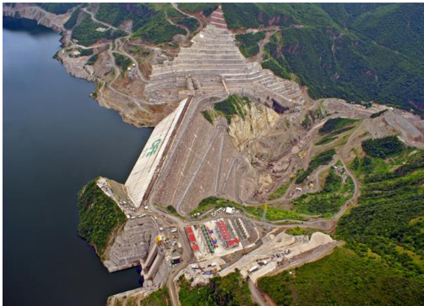
Figura 1.2 Presa Hidroeléctrica La Yesca, ubicada en Nayarit. (Fuente: http://ica.2012.33aws.com/ids-innovacion.html#0 )
