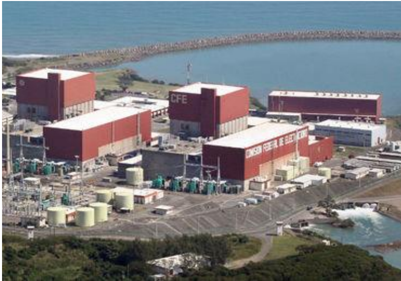
Figura 1.3 Nucleoeléctrica Laguna Verde, ubicada en Veracruz. (Fuente: http://www.informador.com.mx )
