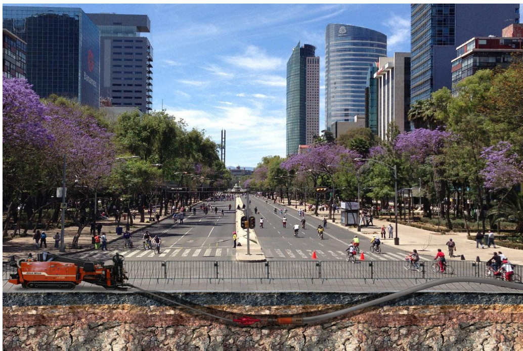
Figura 2.4 Perforación Direccional. (Fuente: http://www.cielco.com.mx/perforacion-horizontal-direccional/ )
