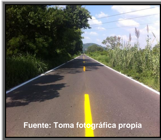
FIGURA 2.- Marcas en el pavimento en carreteras con ancho de arroyo vial de hasta 6,5 m
