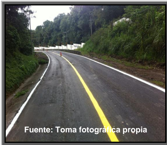
FIGURA 2.- Marcas en el pavimento en carreteras con ancho de arroyo vial de hasta 6,5 m
