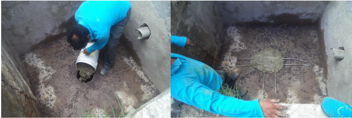
Fotografía 4.2. Relleno con lechada de cemento para pozo a cancelar (izquierda) y parrilla de varilla como protección extra (derecha). Fotógrafo: Calvario Acocal, Florencio. Fecha:18-10-2015
