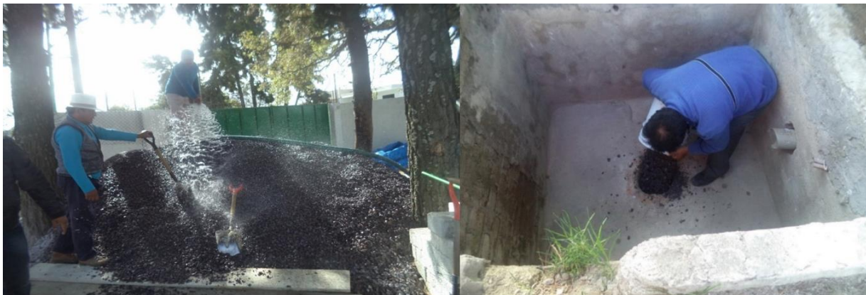
Lavado de grava para no contaminar el manto acuífero (izquierda) y a la derecha el relleno de grava. Fotografía 4.1. Lavado de grava. Fotógrafo: Calvario Acocal, Florencio Fecha:18-10-2015.
