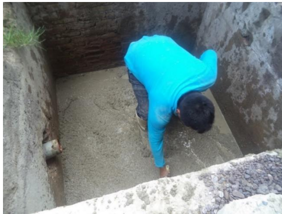
Fotografía 4.3. Plantilla de concreto para pozo cancelado. Fotógrafo: Calvario Acocal, Florencio (18-10-2015)
