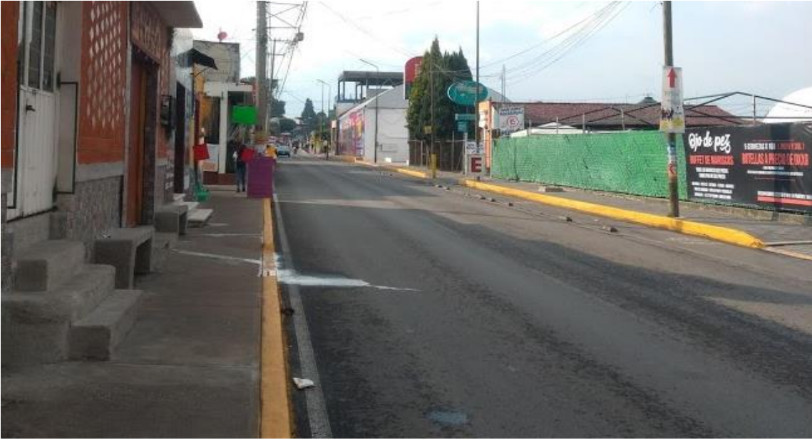
IMAGEN 22. Pavimento Tipo Asfalto, calle 14 Oriente. Fuente: Guarneros, 2019
