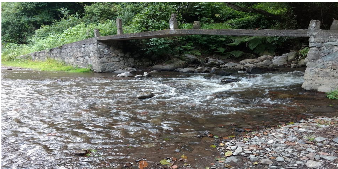
Foto 25. Puente para el paso peatonal. Mayo, 2006. Foto: Magali Mencos.
