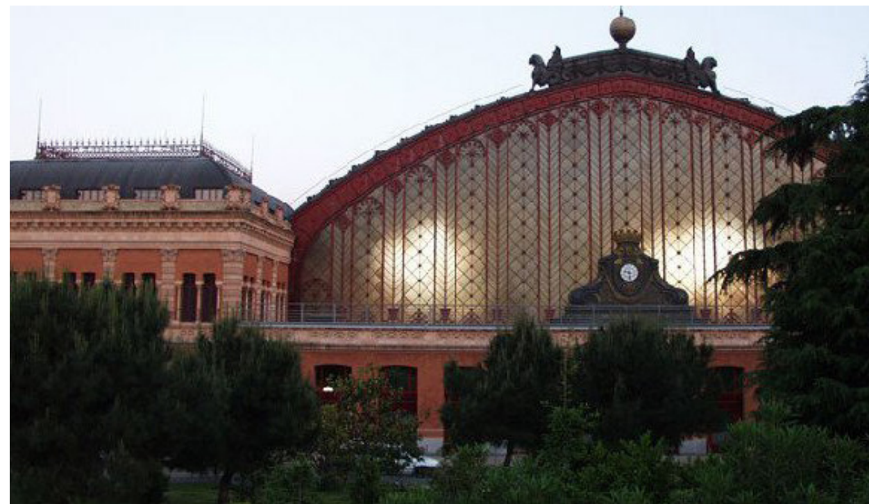
Figura 55. Fachada exterior restaurada y conservada de la Estación de Atocha (Secretaría de Turismo, 2021).
