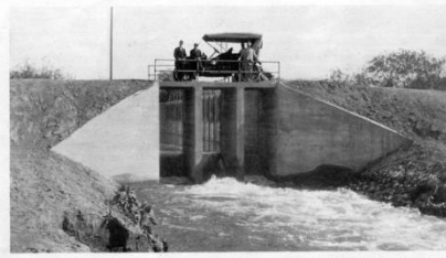
Compuerta controlada por la Compañía en el Canal Principal en el punto donde entran aguas al Canal del Pueblo. Esta compuerta, antes que se usó el freno, servía de obra a los agricultores de las secciones de Cocorit, Balam, y San José. Estas secciones pertenecen al Estado y a la ciudad de San José y durante la sequía que han sufrido en ciertos años, sólo se abren solamente un tercio a la mitad de la total controlada bajo el sistema de la Compañía, han recibido aproximadamente dos tercios partes del agua total suministrada por la Compañía a través de las compuertas bajo dicho sistema.
