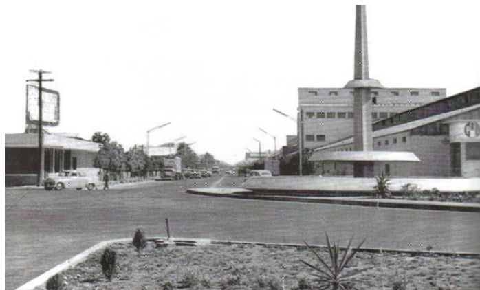
Figura 18. Entrada Sur, Fuente (1965).
