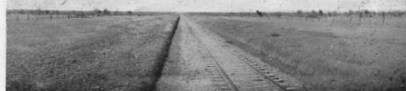
Fue por medio de un Contrato entre la Compañía Constructora Richardson y el Gobierno Mexicano que la Compañía Sud-Pacífico construyó en 1904 el ferrocarril que partiendo de Guaymas atraviesa el Valle del Río Yaqui.
