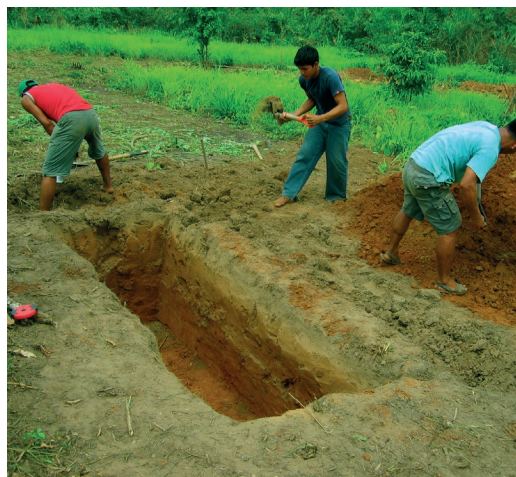
Imagen 5. Construcción de zanjas de infiltración. Fuente: San Francisco Saludable 2008
