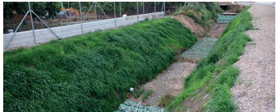
Imagen 12. Desazolve y estabilización con vegetación. Fuente: Mediodes
