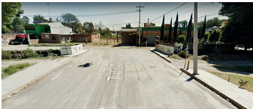
Imagen 45. Estado actual calle 7 de Diciembre. Fuente: Elaboración propia
