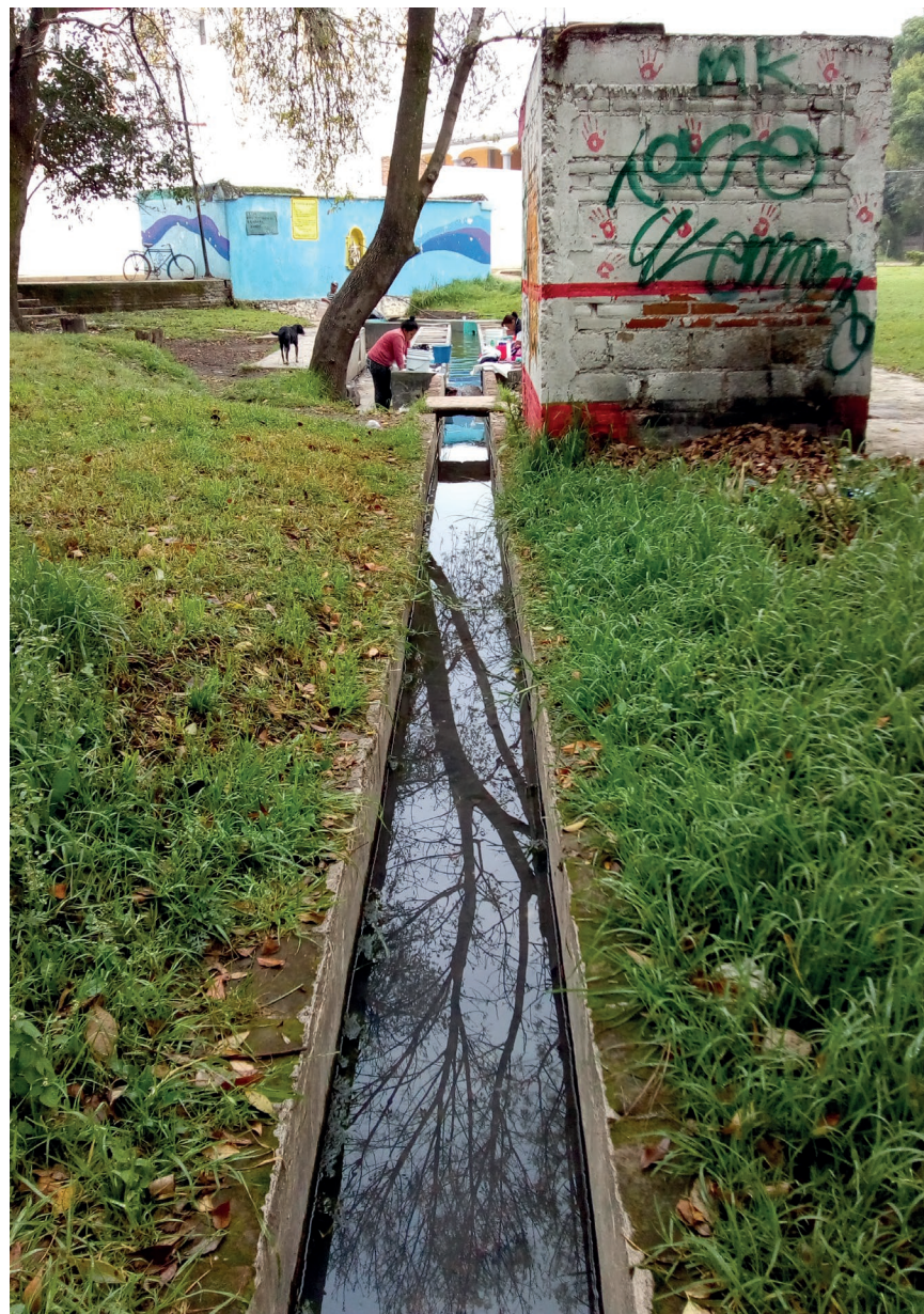
Imagen 24. Agua gris resultado de la actividad que se realiza en la zona de lavaderos. Fuente: Visitas de campo Agosto 2018
