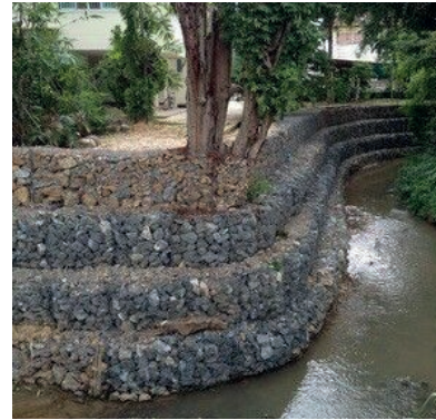
Imagen 10. Muro de gaviones. Fuente: Estefani Fuentes
