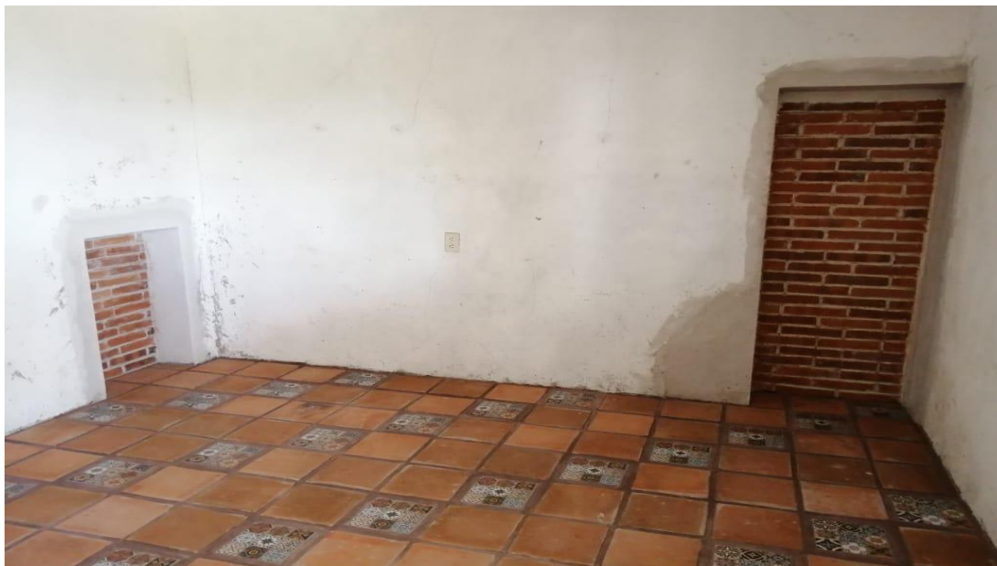
Imagen 4. Piso y arreglos rústicos
