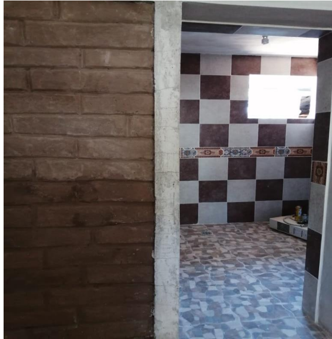
Imagen 5. Piso y arreglos en baño
