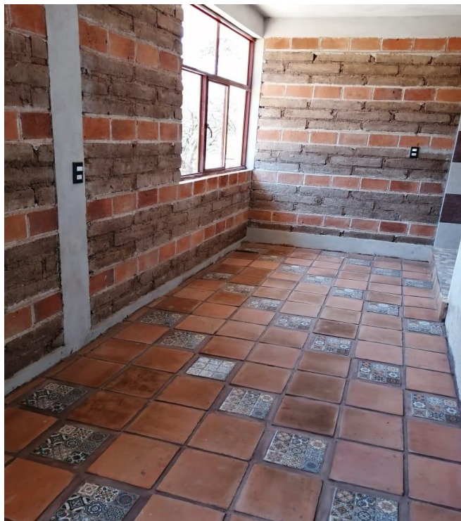
Imagen 6. Vista lateral de la habitación
