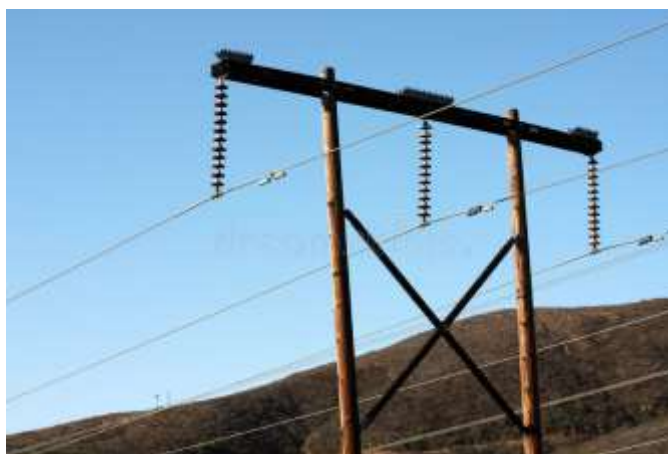
Figura 23 Estructura de madera tipo suspensión
