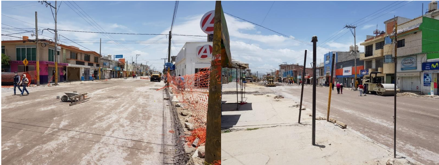
Fotografías de la remodelación de la vialidad 4 norte, (Neri, 2019)
