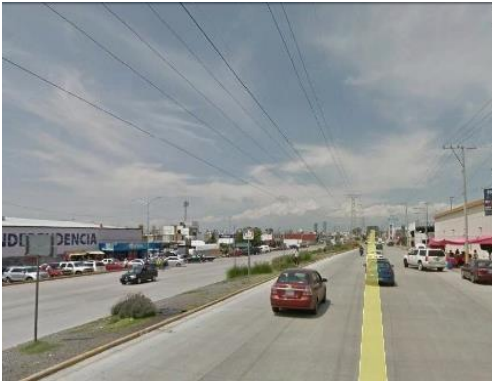
Figura 38: Instalaciones aéreas (electrificación) Fuente: Google Earth
