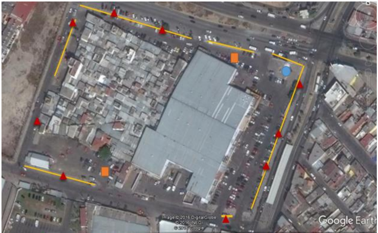
Figura 34: Localización de infraestructura, Mercado Independencia, Puebla, México Fuente: Tomado de Google Earth, Elaboración propia
