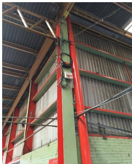
Figura 62: Detalle de muro, techumbre y columna Fuente: Elaboración propia
