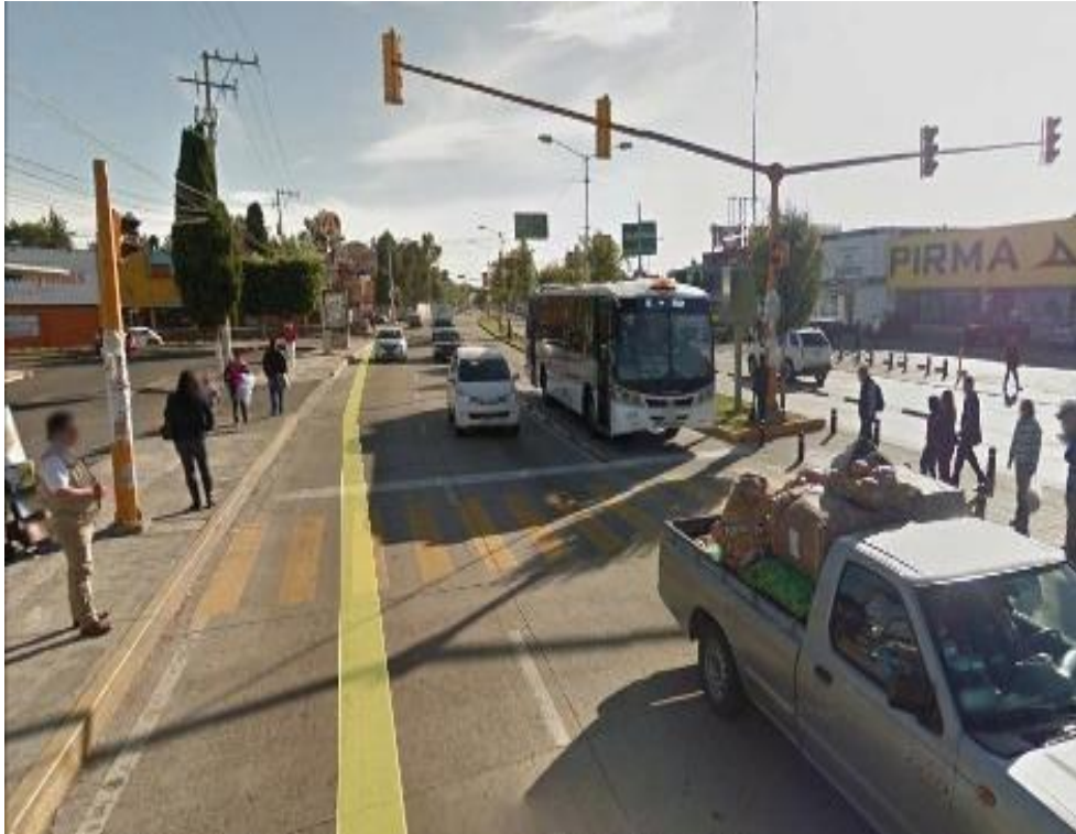
Figura 37: Guarniciones y banquetas Fuente: Google Earth
