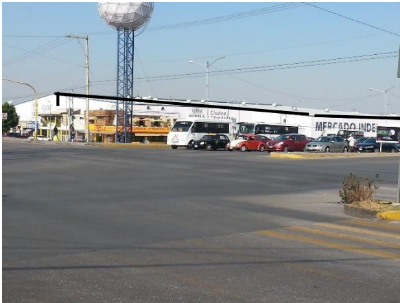
Figura 47: Los perfiles del Mercado Independencia son diferentes debido a la altura y la inclinación de la cubierta Fuente: Elaboración propia
