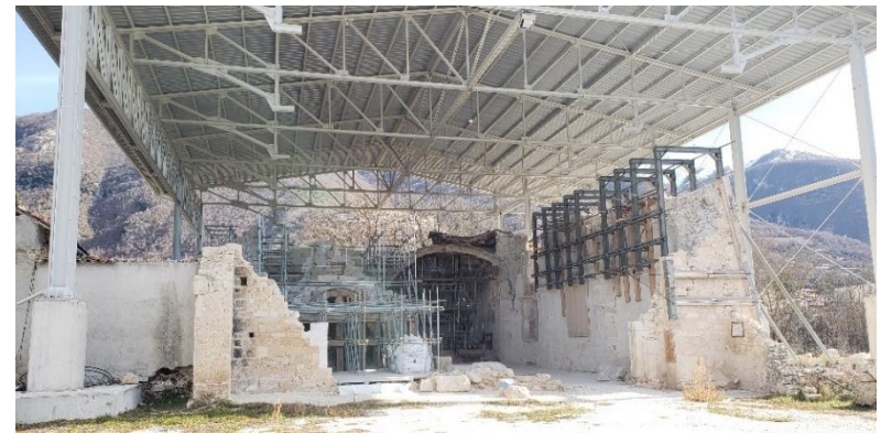
Ilustración 63. Iglesia de San Salvatore in Campi en febrero de 2019, la imagen muestra el sistema de apuntalamiento y la estructura que resguarda al monumento. Fuente: Del Autor
