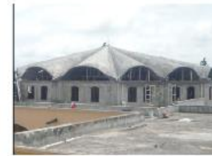
Posibilidades plásticas del sistema. Obra: Cubierta auditorio en San Pedro Cholula, Pue. (2011). Construcción: Arq. Rodolfo Gómez Arias y Arq. Víctor Hernández Cabrera
