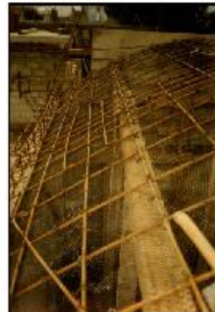
Figura II.12 Descripción de la técnica de bóvedas de concreto armado "sin cimbra" (Sistema CGL-1)
