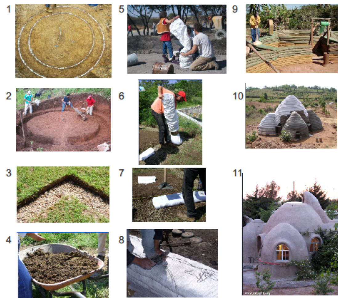
Proceso constructivo del superadobe.
