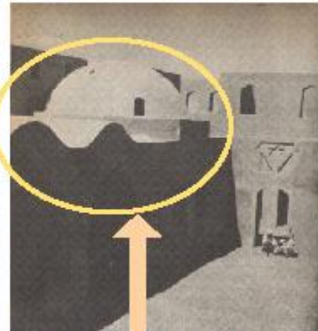
Cúpulas y bóvedas núbicas, un sistema de techado tradicional del Medio Oriente, estético y económico.
