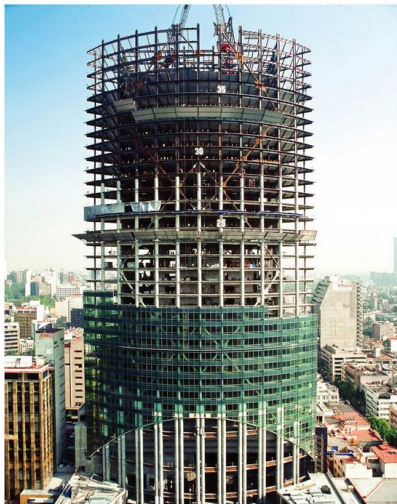
El concepto del proyecto se basa en el sistema denominado tubo en tubo.
