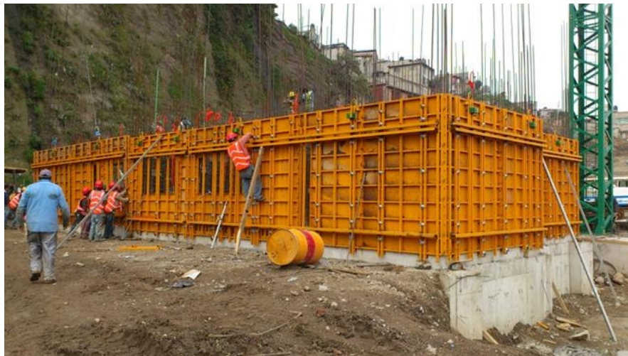
IMAGEN Paneles de acero al exterior planta baja
