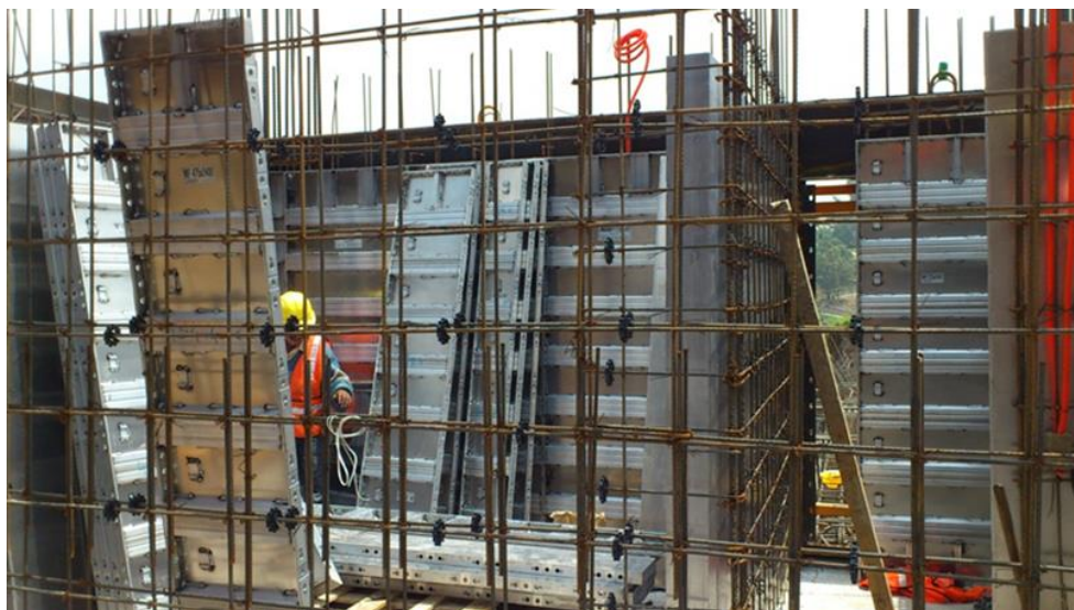
12 El interior está conformado por paneles de aluminio
