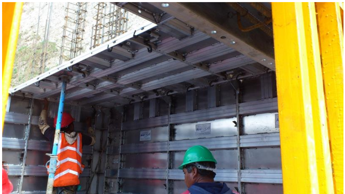
19 cimbrado con paneles de aluminio
