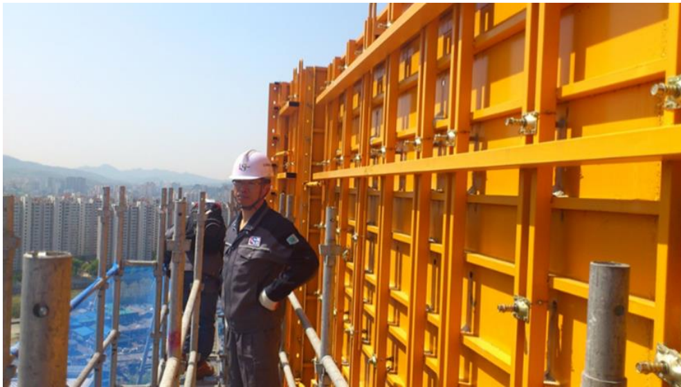
11 Paneles de acero al exterior
