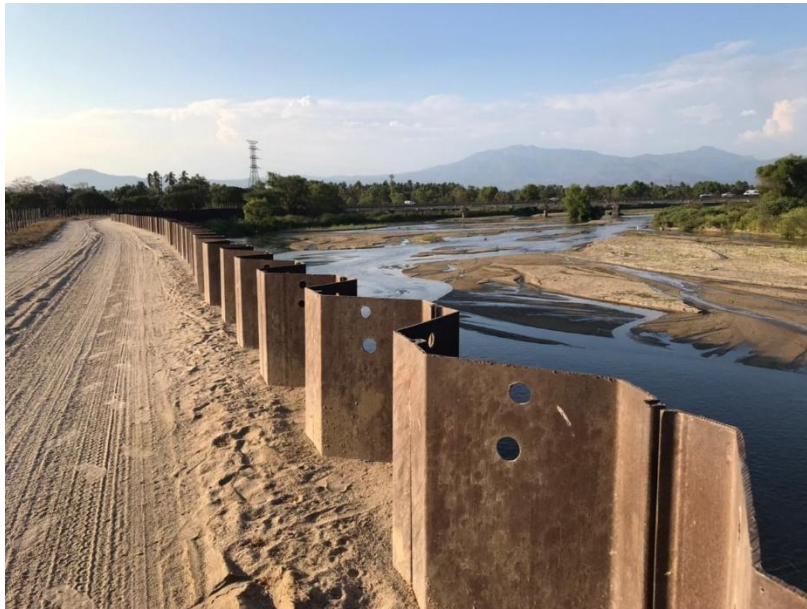
Fig. 45 Flores M., Muro de tablaestaca de acero sobre el bordo del río
