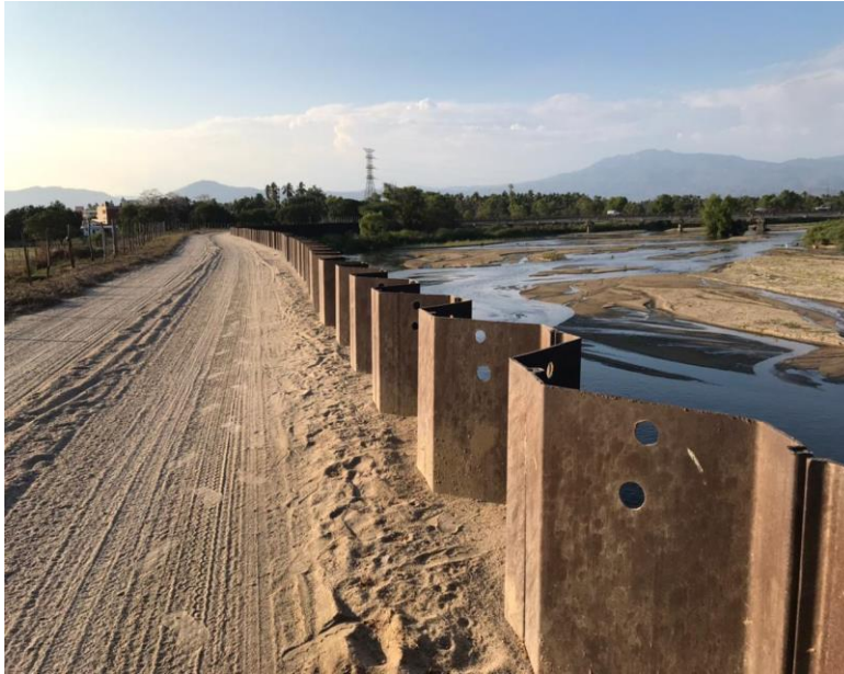
Fig. 35 Flores M., Muro de tablaestaca en el río de San Jerónimo
