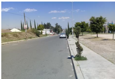
Ilustración 32 pavimentación de carpeta asfáltica Eduardo Saldivar 2019
