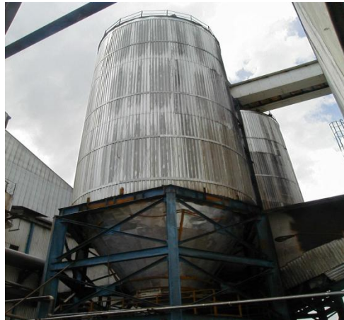
Figura 28. Silo para almacenamiento de azúcar Fuente: Archivo fotográfico ISRP, 2009
