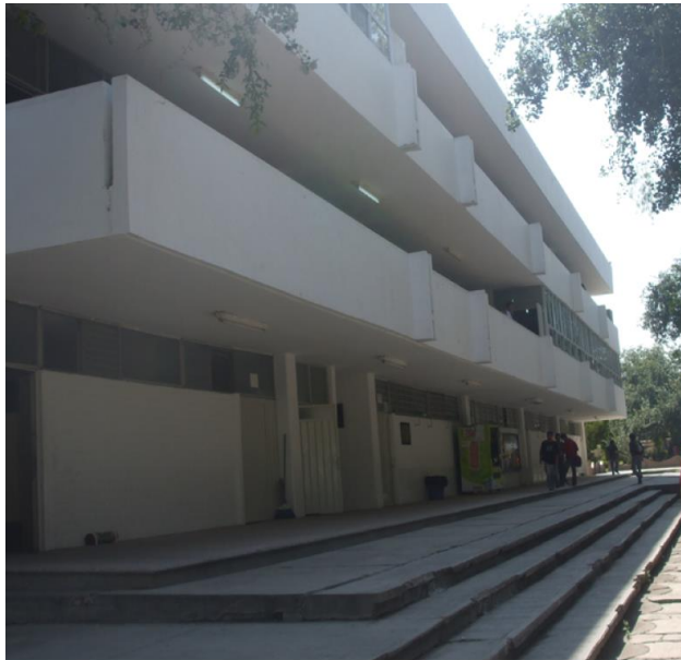
FACHADA SUR. (PRINCIPAL) DE LA FACULTAD DE ELECTRÓNICA 109-A. ANTES. FUENTE: BANCO DE DATOS DE LA DGO (Anexo No.45)
