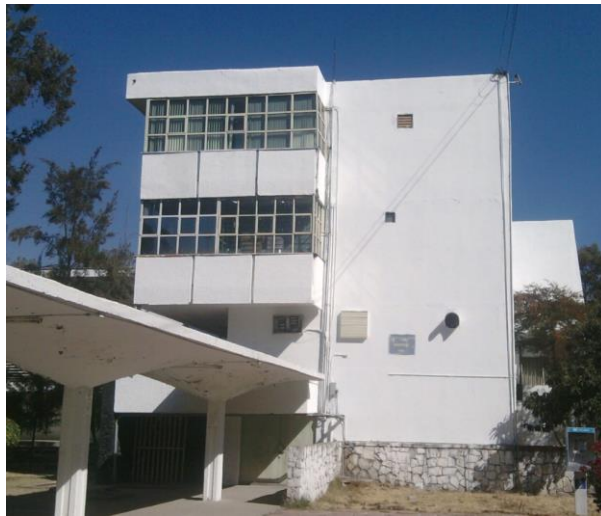
FACHADA SUR. ANTES. EDIFICIO 104-D DE LA FAC. DE CS. DE LA COMPUTACIÓN. FUENTE: ARCHIVO PERSONAL ( Anexo No.127 )
