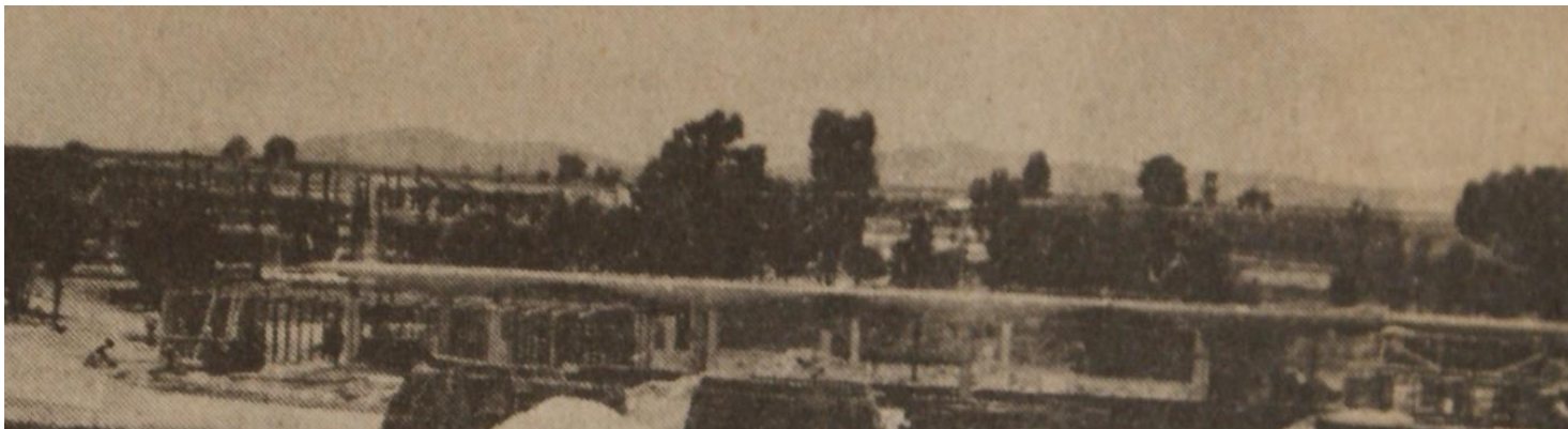
CONSTRUCCIÓN DE LA CIUDAD UNIVERSITARIA FUENTE: NOVEDADES DE PUEBLA. 07 DE AGOSTO DE 1968 (ANEXO No.2)
