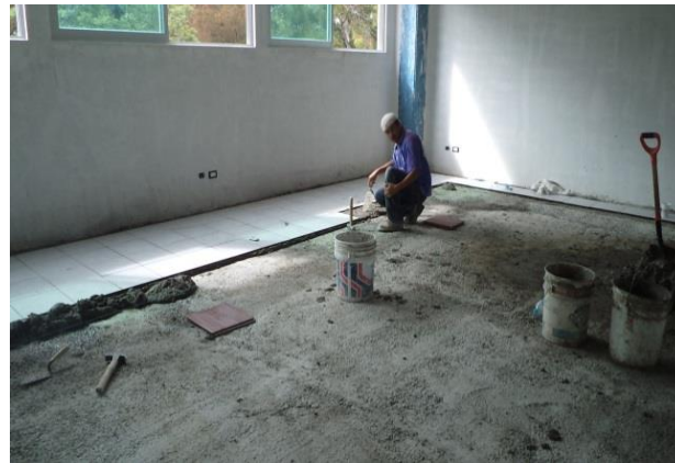
RETIRO DE PISO Y COLOCACIÓN DE PISO NUEVO. 3er. NIVEL. EDIFICIO 104-D DE LA FACULTAD DE CIENCIAS DE LA COMPUTACIÓN. FUENTE: ARCHIVO PERSONAL ( Anexo No.112 )
