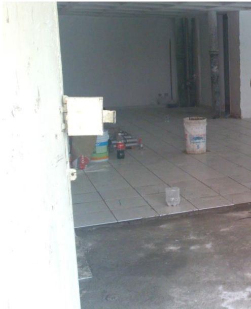
COLOCACIÓN DE PISOS, ZOCLO. EDIFICIO 104-D DE LA FACULTAD DE CIENCIAS DE LA COMPUTACIÓN. FUENTE: ARCHIVO PERSONAL ( Anexo No.116 )
