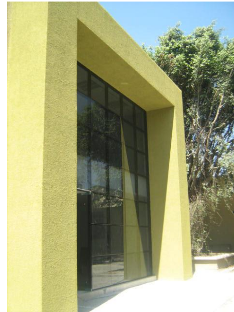
PÓRTICO EN FACHADA ORIENTE. FISIOLÓGIA EDIFICIO 102-B BIOMEDICINA FUENTE: BANCO DE DATOS DE LA DGO ( Anexo No.68 )
