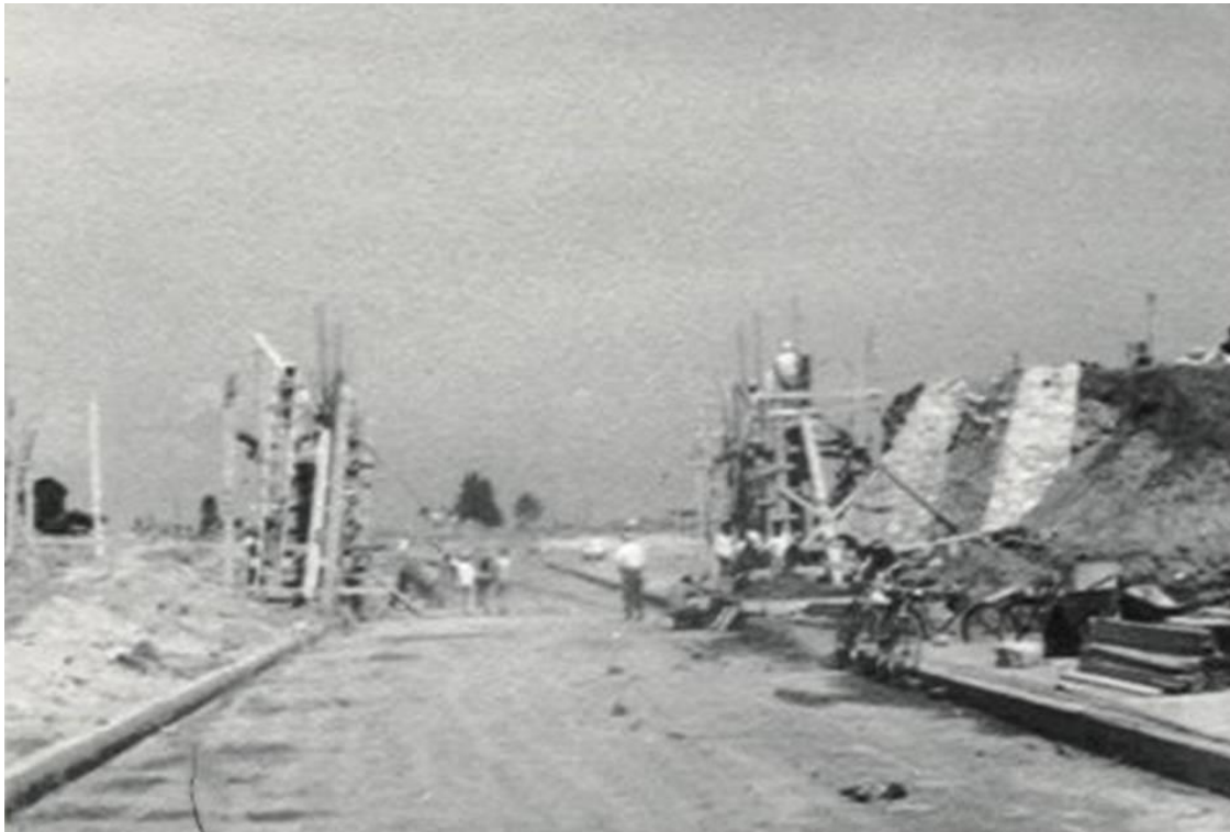
CONSTRUCCIÓN DE TERRAPLENES Y ENCOFRADO DE COLUMNAS DEL PUENTE PEATONAL (ACTUALMENTE COMUNICA DE INGENIERÍAS Y DGO HACIA ZONA DEPORTIVA)
