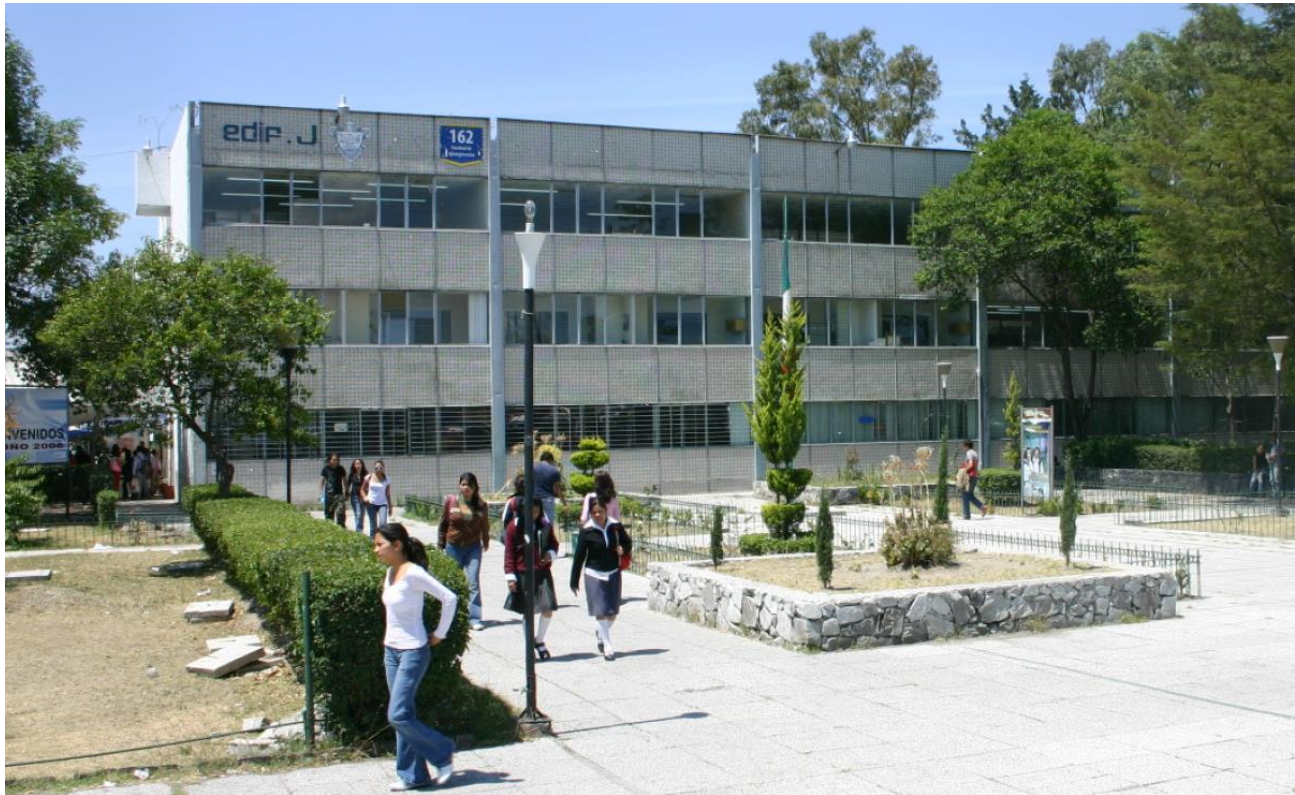
FACHADA NORTE. (PRINCIPAL) DE LA FACULTAD DE ADMINISTRACIÓN. ANTES. FUENTE: BANCO DE DATOS DE LA DGO ( Anexo No.28 )
