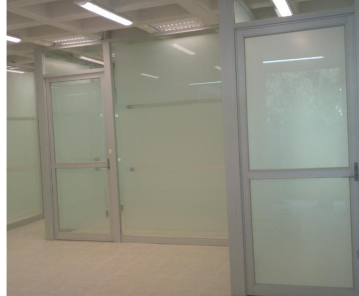
COLOCACIÓN DE CANCELERÍA PARA ÁREA ADMINISTRATIVA PRIMER NIVEL. EDIFICIO 104-D DE LA FAC. DE CS. DE LA COMPUTACIÓN. FUENTE: ARCHIVO PERSONAL ( Anexo No.125 )
