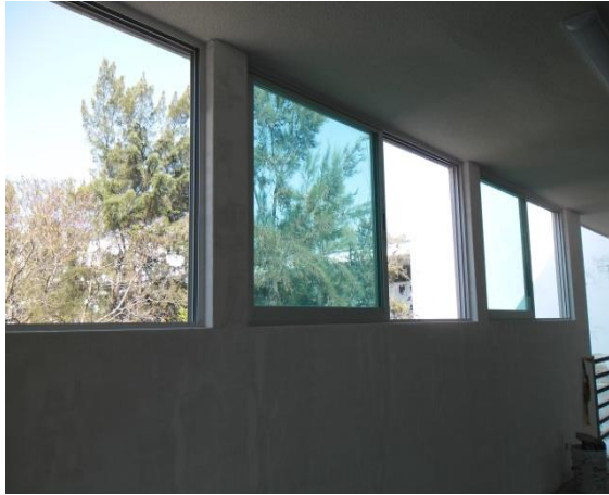
CAMBIO DE VENTANAS. RESANES EN PLAFON. REBATIDO EN MUROS. 3er. NIVEL. EDIFICIO 104-D DE LA FACULTAD DE CIENCIAS DE LA COMPUTACIÓN. FUENTE: ARCHIVO PERSONAL ( Anexo No.111 )
