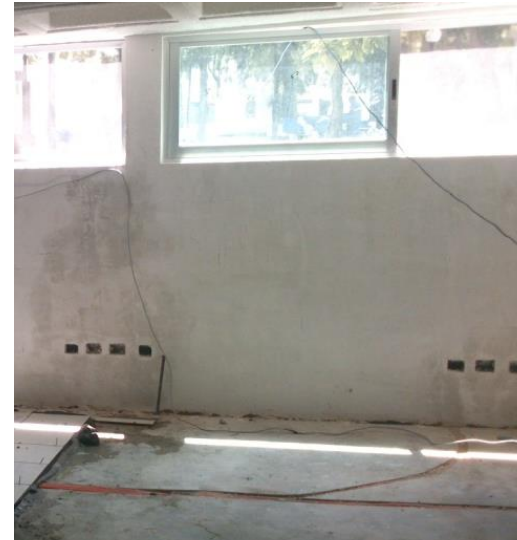
RESANE EN INTERIORES. EDIFICIO 104-D DE LA FACULTAD DE CIENCIAS DE LA COMPUTACIÓN. FUENTE: ARCHIVO PERSONAL ( Anexo No.121 )
