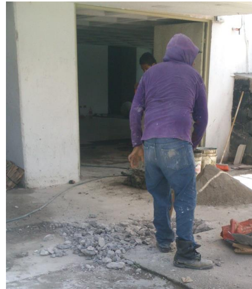
DEMOLICIÓN DE PISO PARA NIVELLO. EDIFICIO 104-D DE LA FACULTAD DE CIENCIAS DE LA COMPUTACIÓN. FUENTE: ARCHIVO PERSONAL ( Anexo No.119 )
