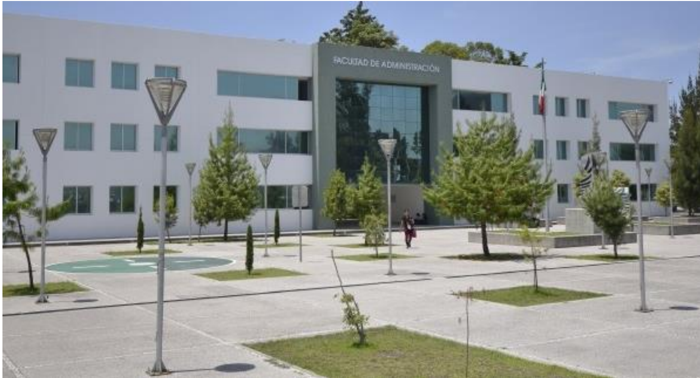
FACHADA NORTE. (PRINCIPAL) DE LA FACULTAD DE ADMINISTRACIÓN. DESPUÉS. FUENTE: BANCO DE DATOS DE LA DGO (Anexo No.31)
